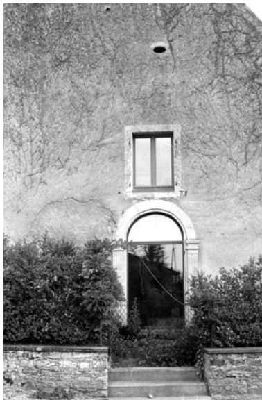
Porte d'entrée. Phot. Bernard Lardière IVR43_19817000735Z
