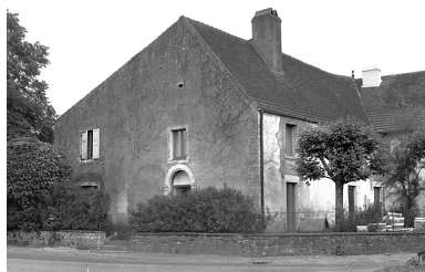
Façade sur rue. Phot. Bernard Lardière IVR43_19817000734Z
