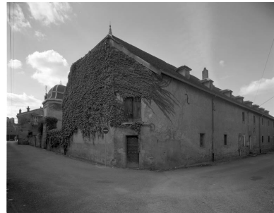
Façades postérieure et latérale droite de l'entrepôt.
