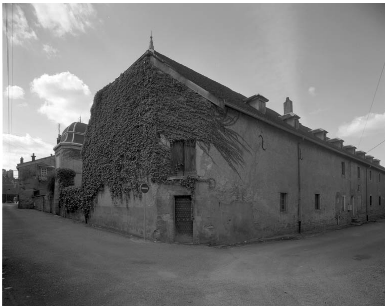
Façades postérieure et latérale droite de l'entrepôt.
