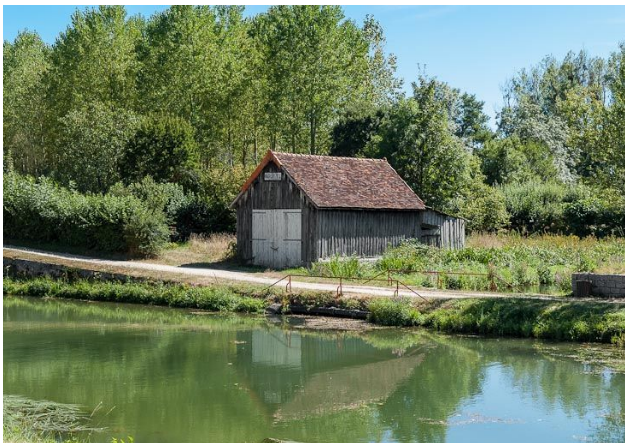
La remise, vue d'ensemble.
