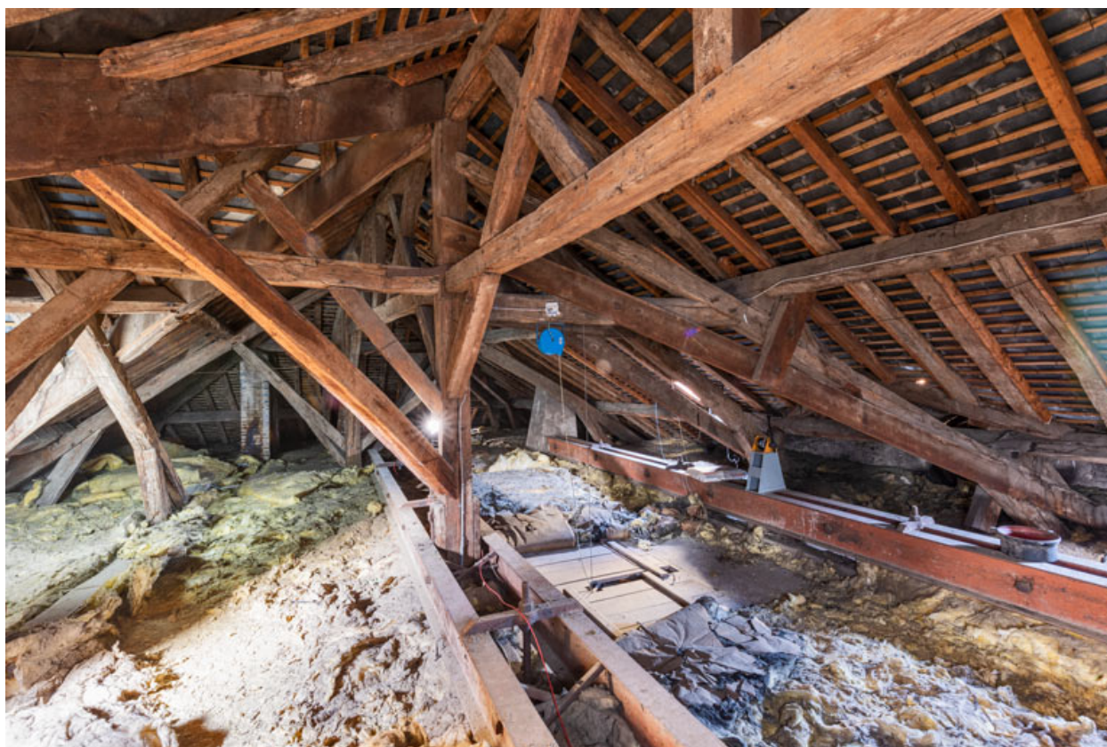
Comble à surcroît.
