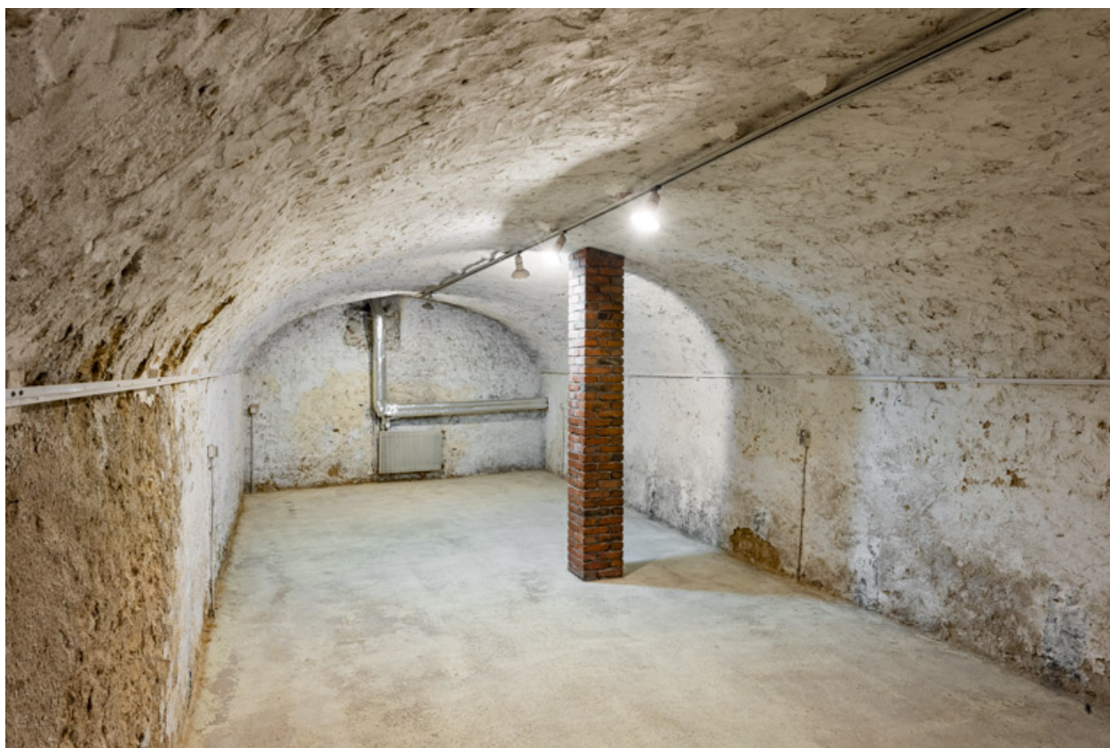
Cave voûtée en sous-sol.
