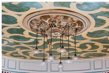
Plafond et lustre. Phot. Pierre-Marie Barbe-Richaud IVR26_20238900324NUC4A
