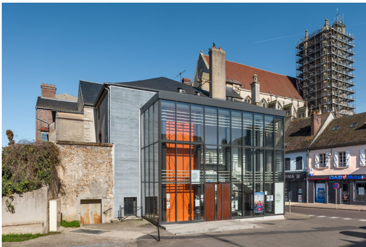
Façade latérale gauche, de trois quarts gauche.
