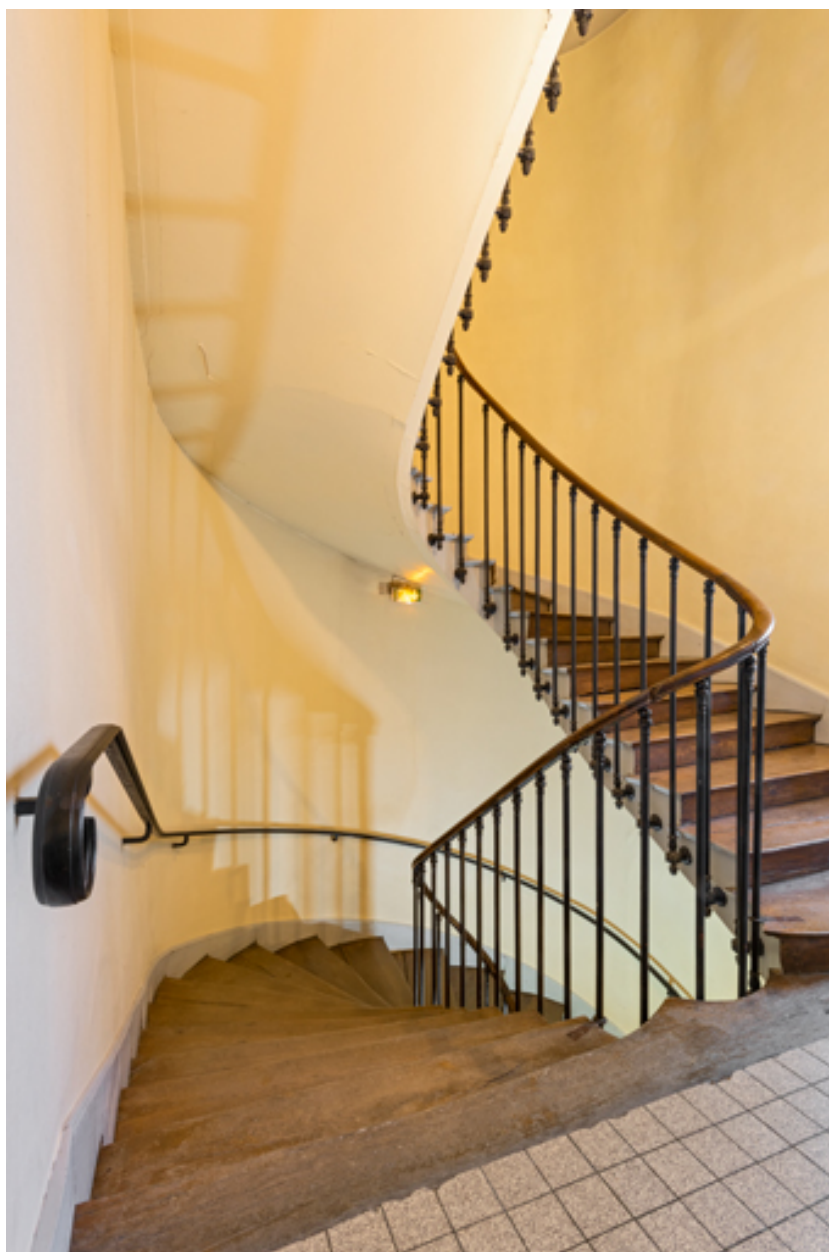
Escalier, au palier de l'étage carré.
