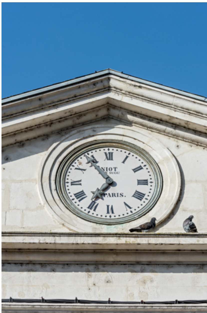
Façade antérieure, avant-corps central : horloge Niot.
