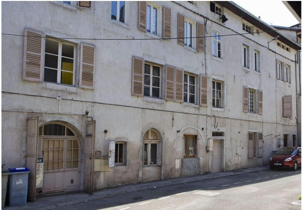
Elévation postérieure, rue des Promenades.
