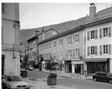
Vue d'ensemble, rue de la République. Phot. Yves Sancey IVR43_20033900774V
