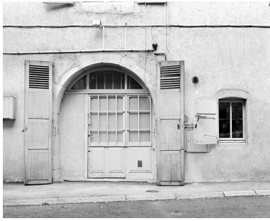
Baie en arc plein cintre. Phot. Yves Sancey IVR43_20033900777X
