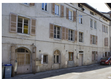
Elévation postérieure, rue des Promenades. Phot. Yves Sancey IVR43_20103900469NUC2A
