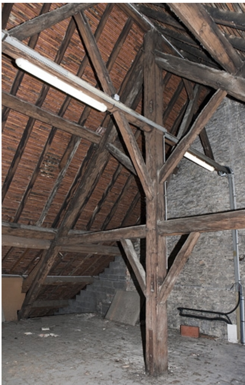
Intérieur, comble : détail de la charpente.
