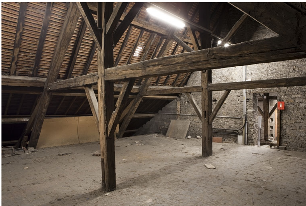
Intérieur, comble : détail de la charpente.
