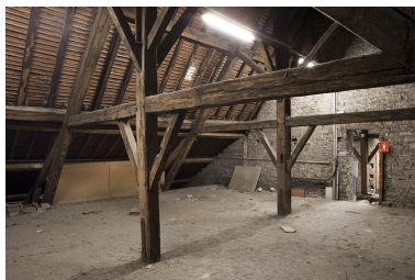
Intérieur, comble : détail de la charpente.
