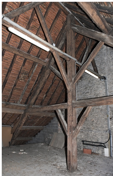
Intérieur, comble : détail de la charpente.
