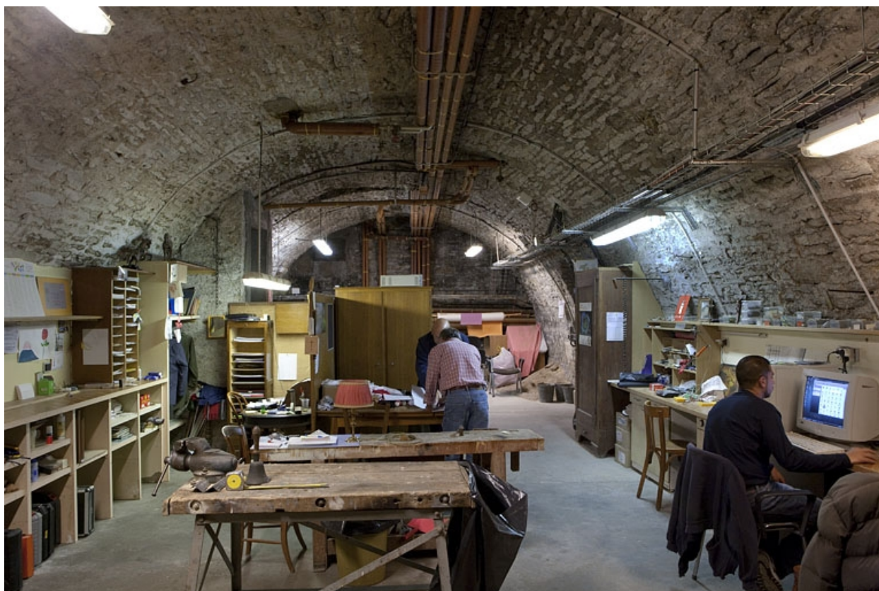
Intérieur, sous-sol : vue d'ensemble d'une cave.
