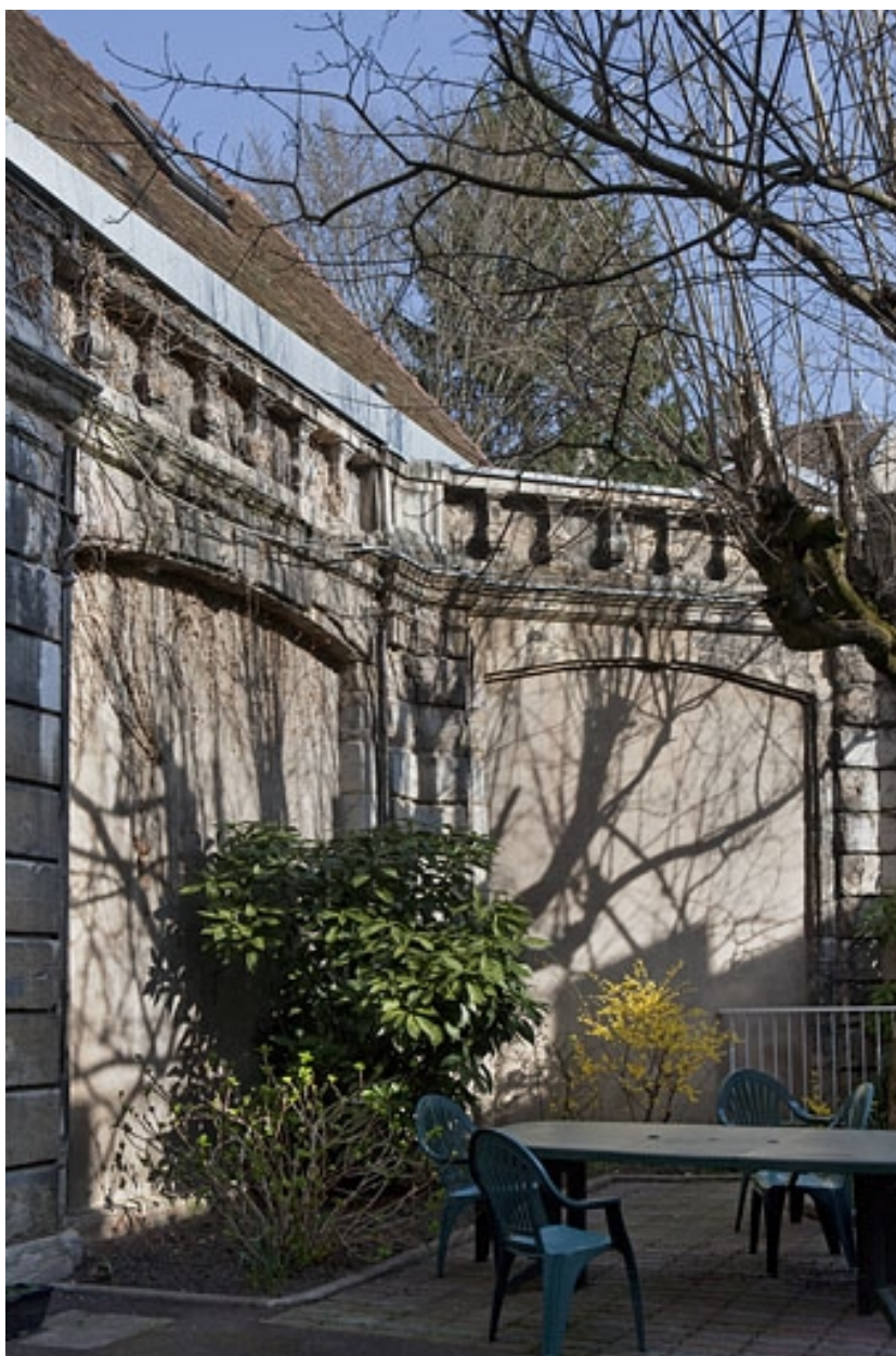
Cour : vue des anciennes remises.
