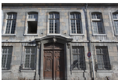
Façade antérieure sur rue : vue de face. Phot. Yves Sancey IVR43_20102500901NUC2A
