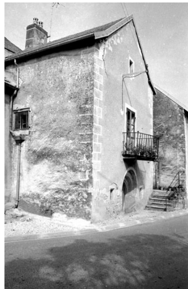
Façade sur rue. Phot. Bernard Lardière IVR43_19797000017Z
