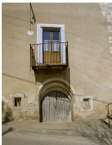
Entrée de la cave. Phot. Yves Sancey IVR43_19827000503XA
