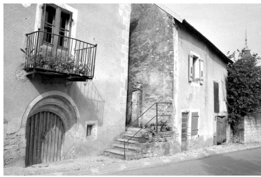
Façade sur rue. Phot. Bernard Lardière IVR43_19797000018Z
