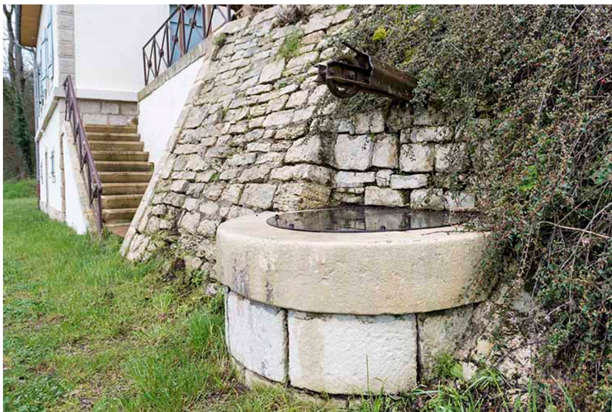
Puits de la maison.
