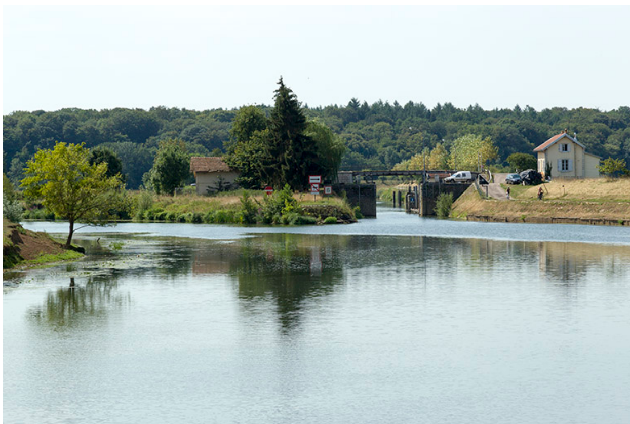
Entrée du canal de navigation de Cubry-lès-Soing.
