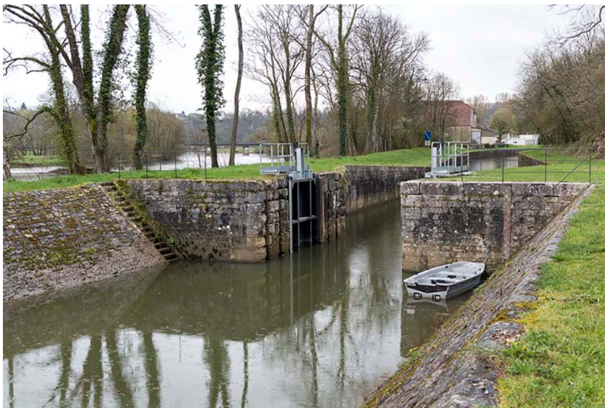
La maçonnerie de la porte de garde.
