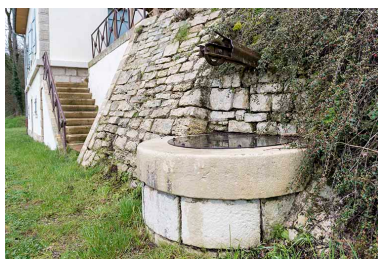
Puits de la maison. Phot. Sonia Dourlot IVR43_20157001546NUC4A
