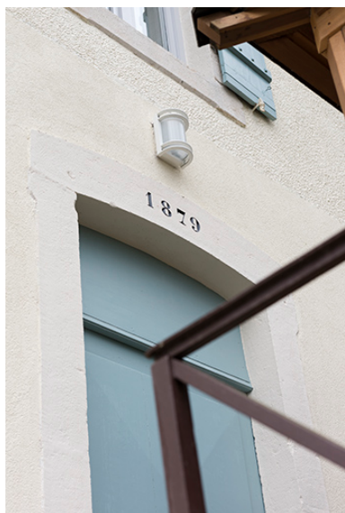
Date portée sur la maison d'éclusier. Phot. Sonia Dourlot IVR43_20157001545NUC4A
