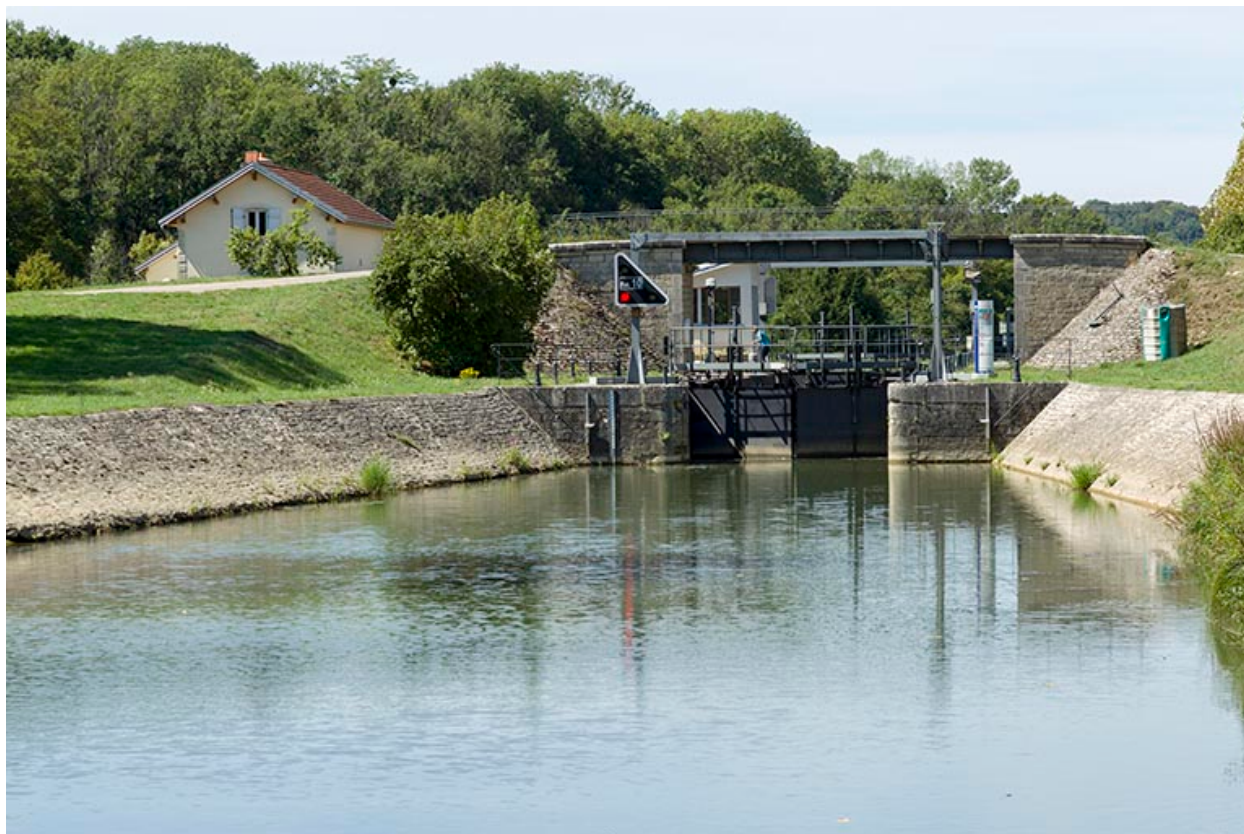
Entrée amont de l'écluse à sas de Soing.
