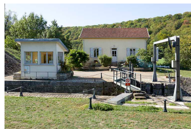
Le site d'écluse de Soing, dernier ouvrage du bief de Soing. Phot. Sonia Dourlot IVR43_20157000814NUC2A
