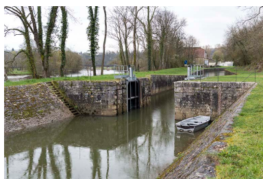
La maçonnerie de la porte de garde. Phot. Sonia Dourlot IVR43_20157001543NUC4A
