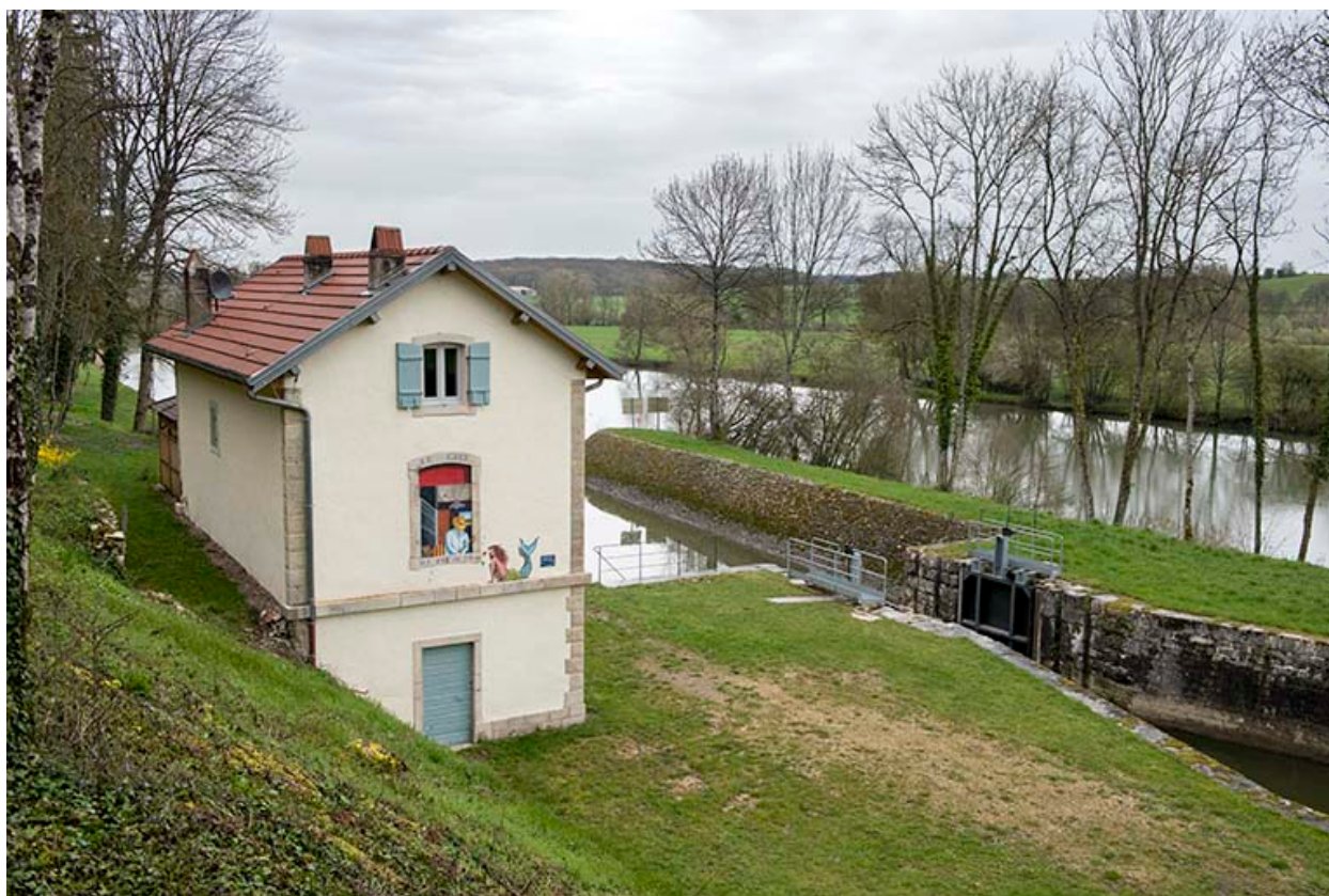
le site d'écluse, vue d'ensemble.
