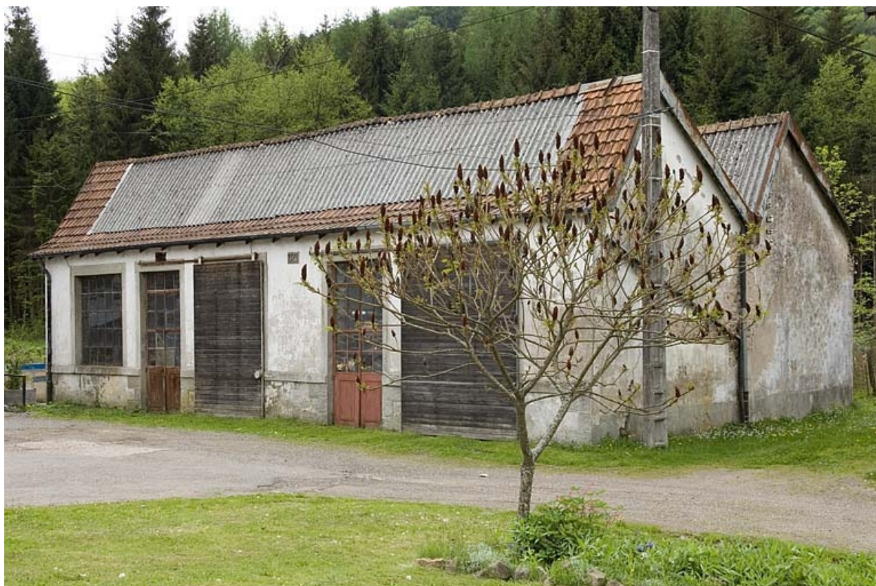
Atelier de réparation (menuiserie, forge).
