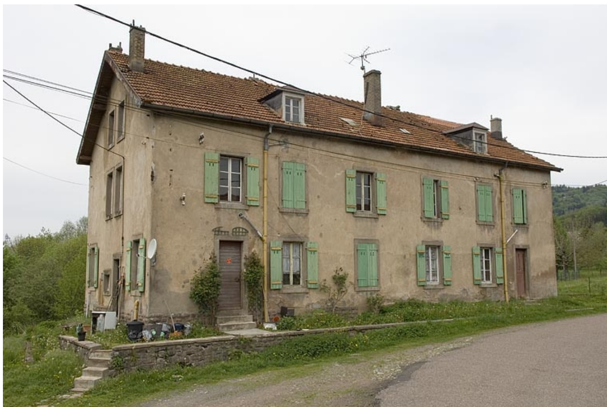
Logement ouvrier collectif.
