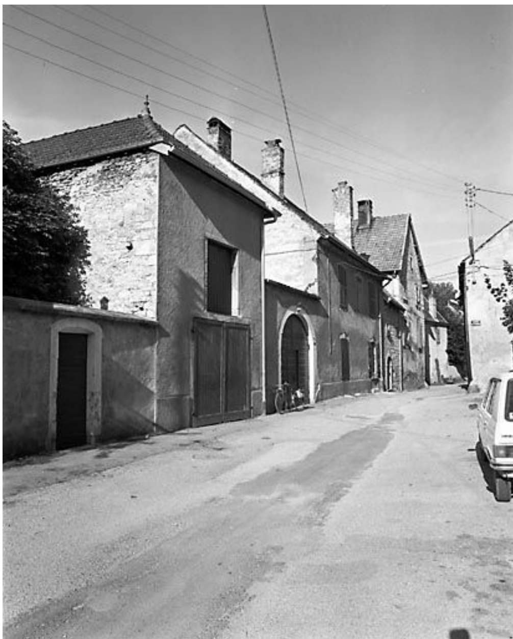
Maison située 3 rue Carnot.
