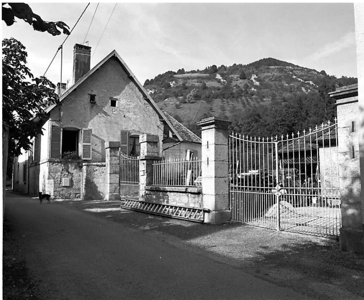
Maison située 14 rue Carnot.
