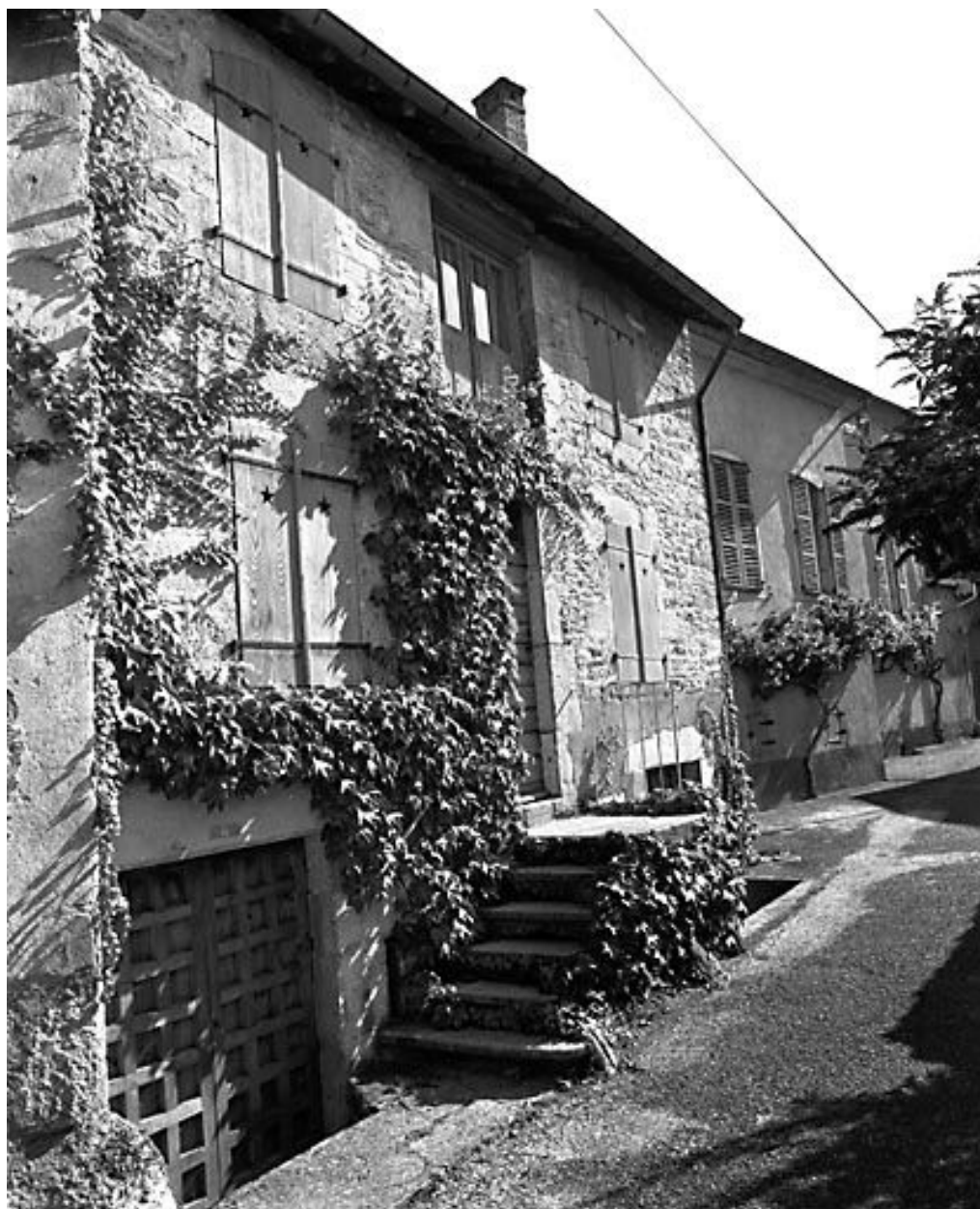
Maison de vigneron située 4 rue du Téméraire.
