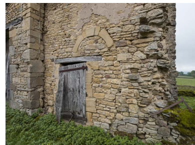
Extrémité de la grange, à l'est de la cour. La maçonnerie conserve l'arc en plein cintre (avec agrafe) qui couvrait l'ancienne porte de la chapelle et les traces d'arrachements d'un mur qui devait clôturer la cour intérieure du château. Phot. Pierre-Marie Barbe-Richaud IVR26_20197100390NUC4AQ
