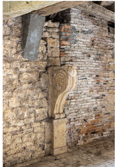
Vestige de la cheminée du second étage de la tour : console à décor de volute et coquille supportant à l'origine le manteau de la cheminée Phot. Pierre-Marie Barbe-Richaud IVR26_20197100383NUC4A
