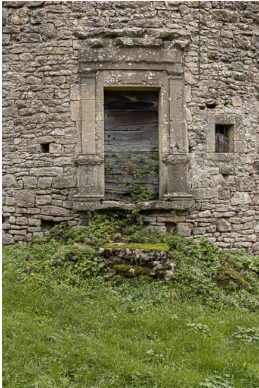
Porte de la tour avec pilastres et entablement, donnant accès à un escalier en vis
