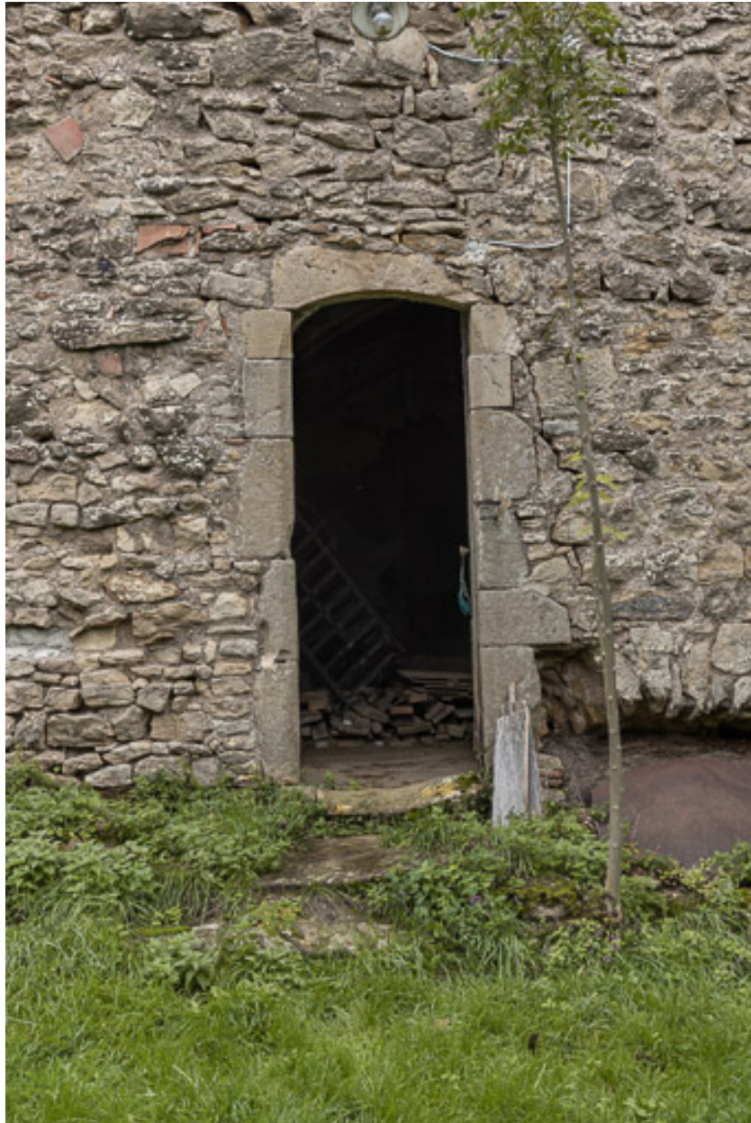
Porte d'accès au rez-de-chaussée de la tour
