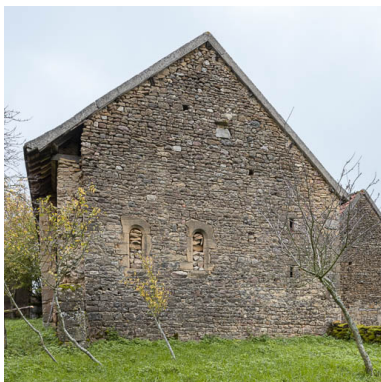
Mur-pignon sud de la grange. Deux anciennes baies cintrées, aujourd'hui bouchées, éclairaient à l'origine l'intérieur de la chapelle. Phot. Pierre-Marie Barbe-Richaud
