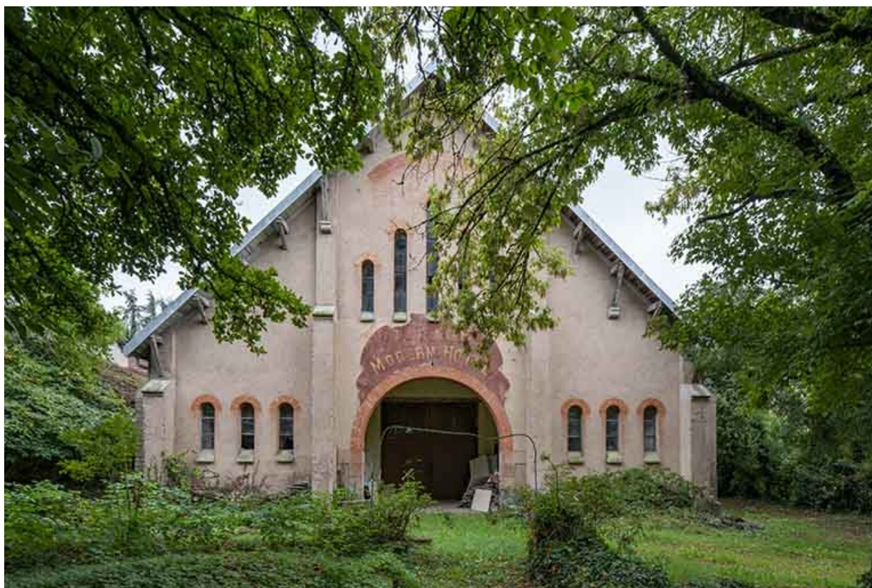
Mur-pignon nord, vue de face.
