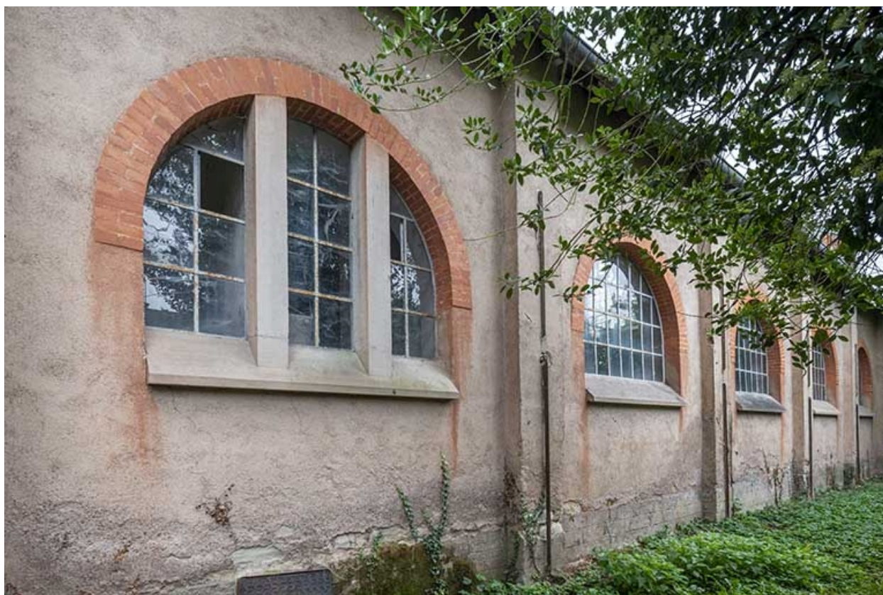
Mur-gouttereau ouest, fenêtre thermique.
