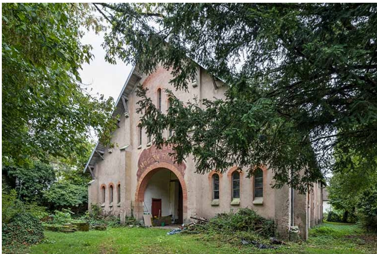
Mur-pignon nord, vue de trois quarts.
