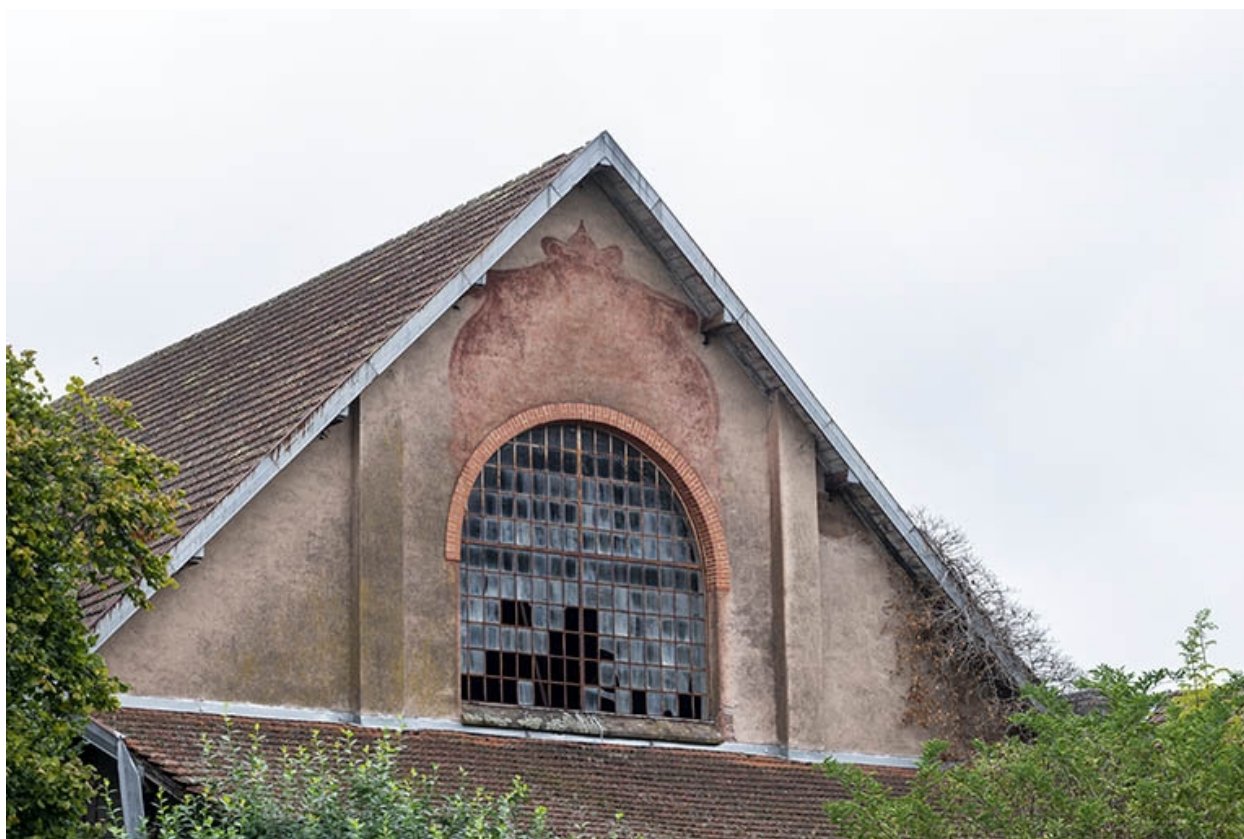
Mur-pignon sud, baie du pignon.
