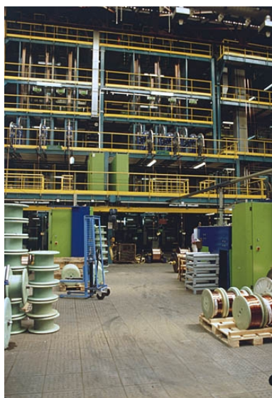
Elévation intérieure de l'atelier d'émaillage.
