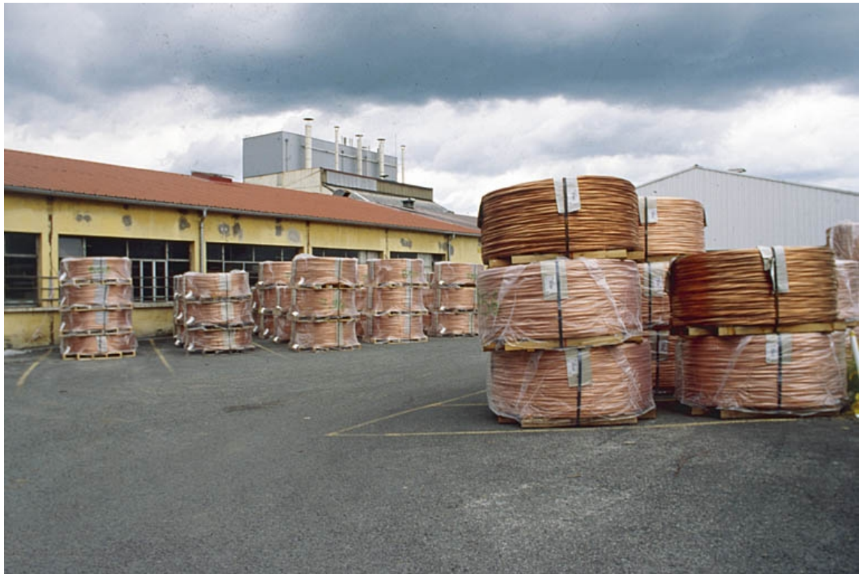
Aire des matières premières (bobines de cuivre).
