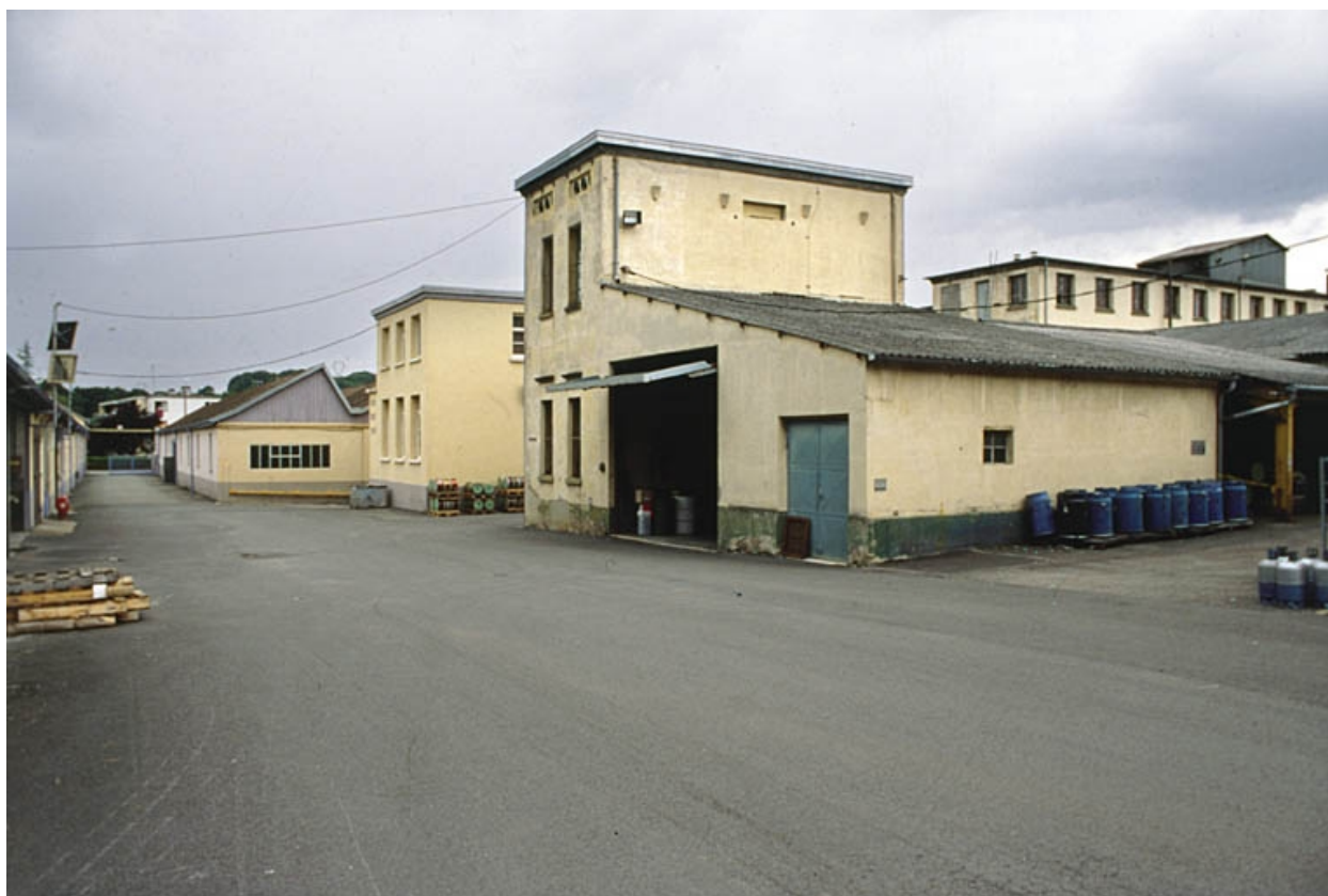
Atelier de fabrication, bureau d'études et transformateur.
