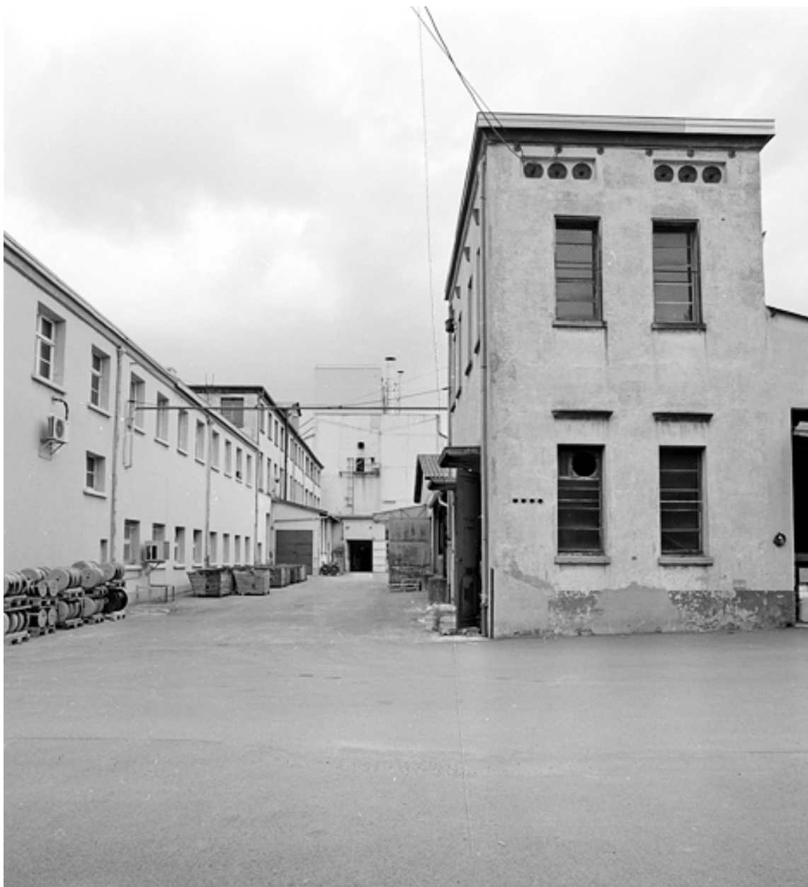
Bureau d'études (à gauche) et transformateur.
