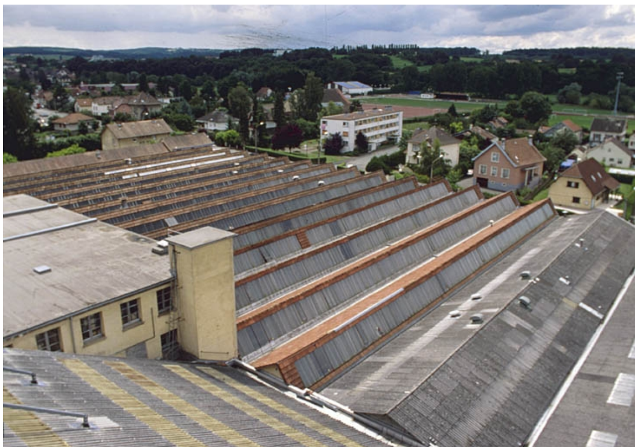
Toitures des ateliers de fabrication en rez-de-chaussée.
