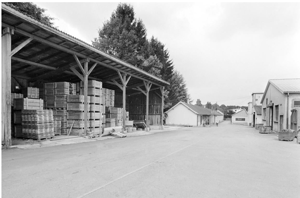
Entrepôt industriel et ateliers divers au sud.
