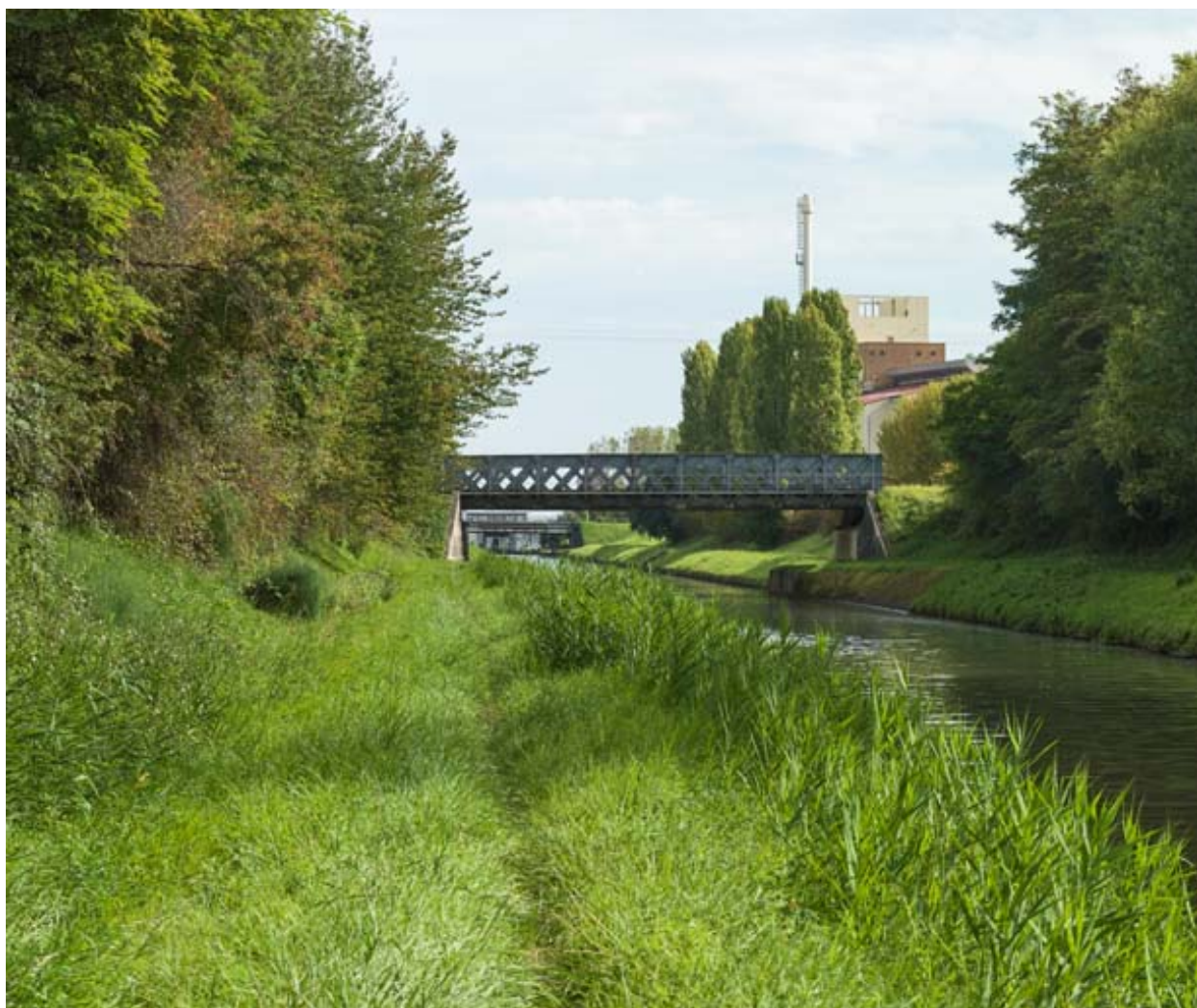
Vue d'ensemble du pont.
