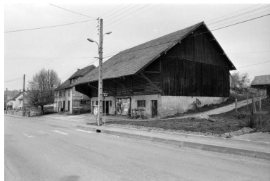
Vue d'ensemble. Phot. Bernard Lardière IVR43_19829000216Z
