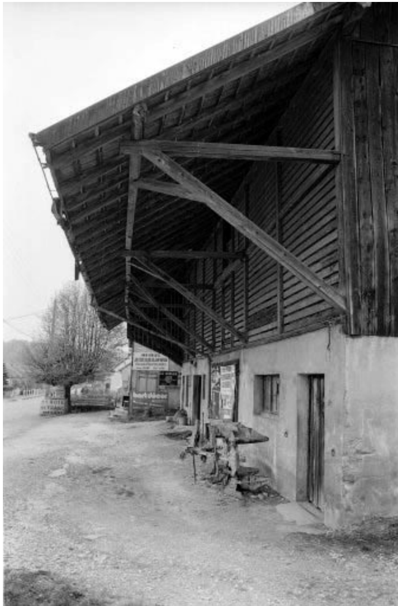
Partie agricole : avant-toit sur façade antérieure.
