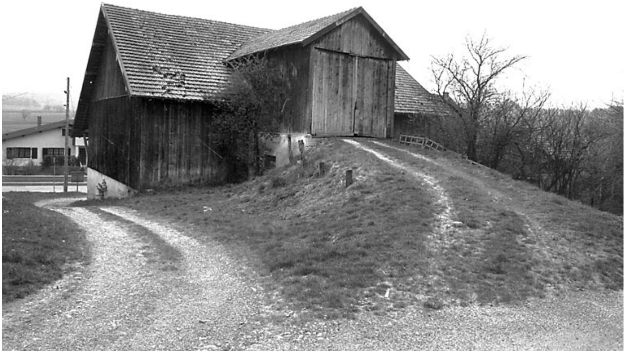
Partie agricole : façade postérieure.
