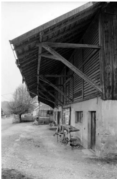
Partie agricole : avant- toit sur façade antérieure. Phot. Bernard Lardière IVR43_19829000217Z
