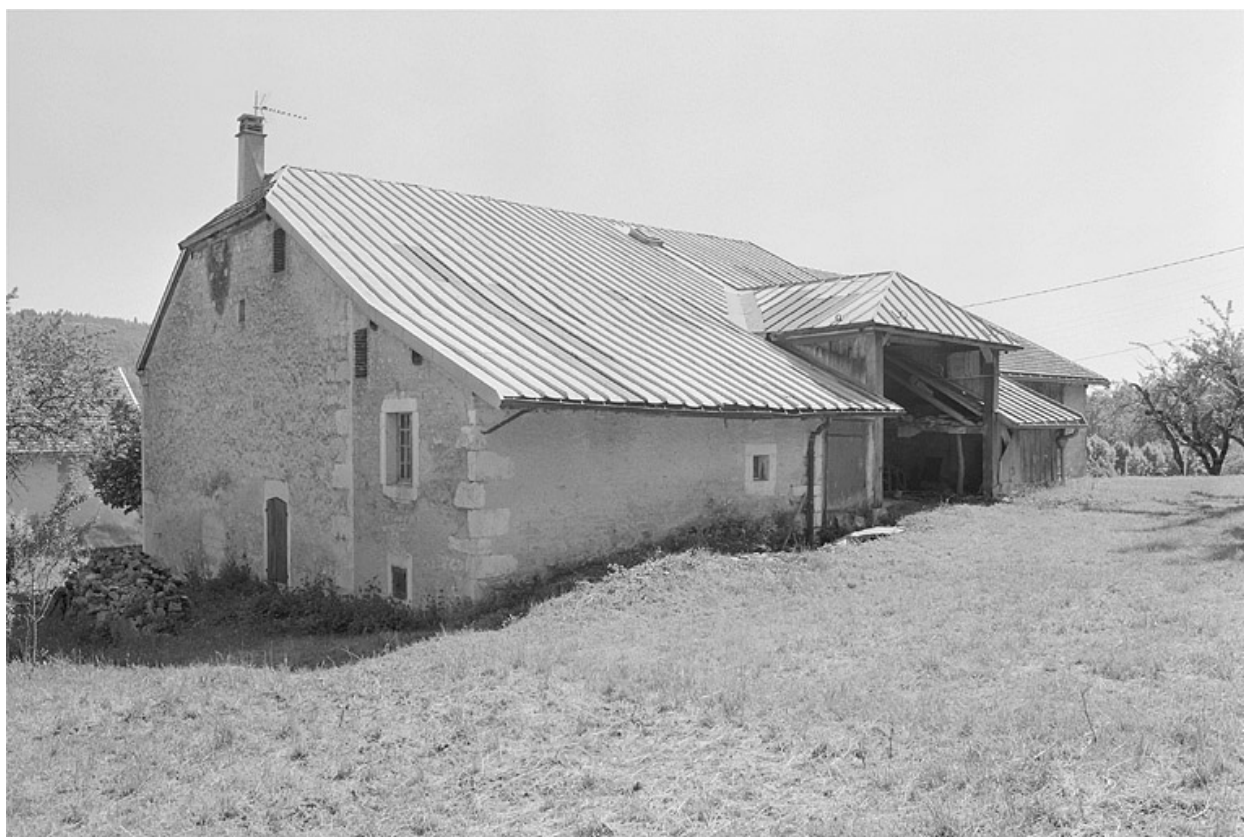
Façade postérieure et face droite.
