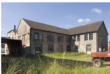
Atelier de fabrication originel. Vue de trois quarts arrière. Phot. Jérôme Mongreville IVR43_20097000413NUC2A
