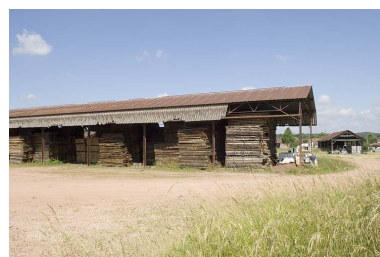
Entrepôts industriels ouest. Phot. Jérôme Mongreville IVR43_20097000416NUC2A
