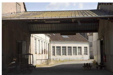
Atelier de fabrication originel. Vue depuis l'ouest Phot. Jérôme Mongreville IVR43_20097000415NUC2A
