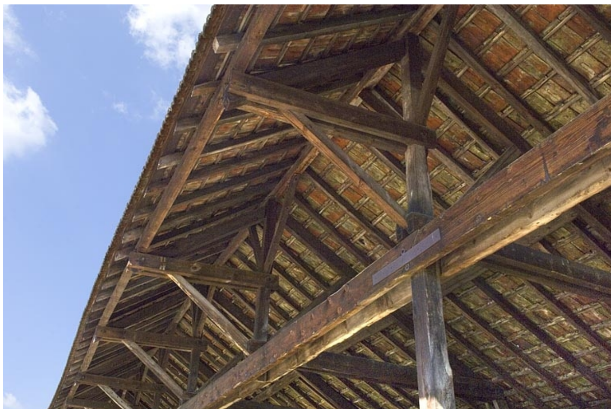
Entrepôt industriel ouest. Détail de la charpente.
