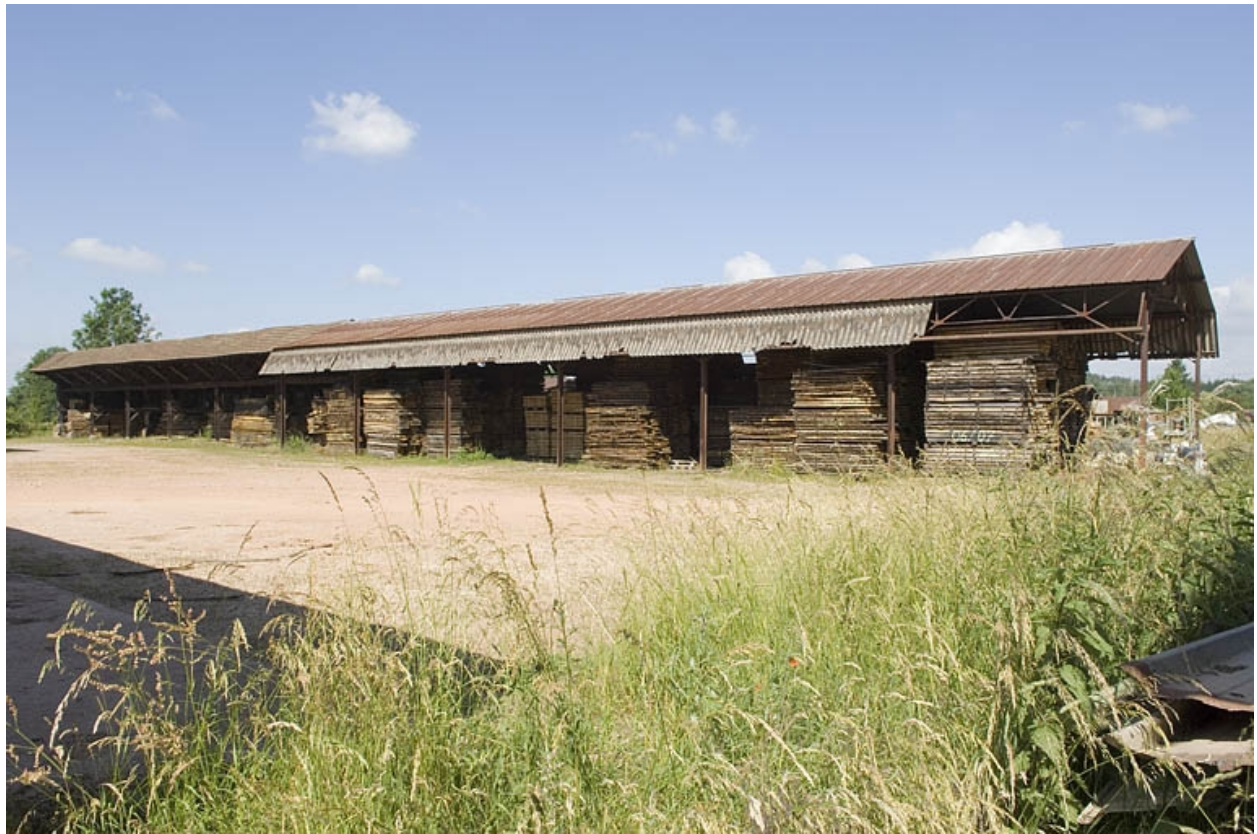
Entrepôt industriel ouest. Vue d'ensemble.
