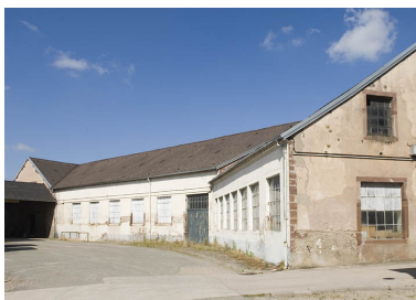
Atelier de fabrication originel. Vue depuis l'est. Phot. Jérôme Mongreville IVR43_20097000411NUC2A
