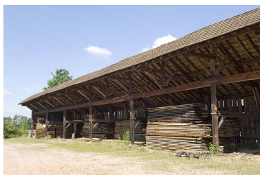
Entrepôt industriel ouest. Vue de trois quarts. Phot. Jérôme Mongreville IVR43_20097000418NUC2A
