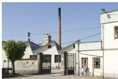
Vue de l'entrée. Phot. Jérôme Mongreville IVR43_20097000406NUC2A
