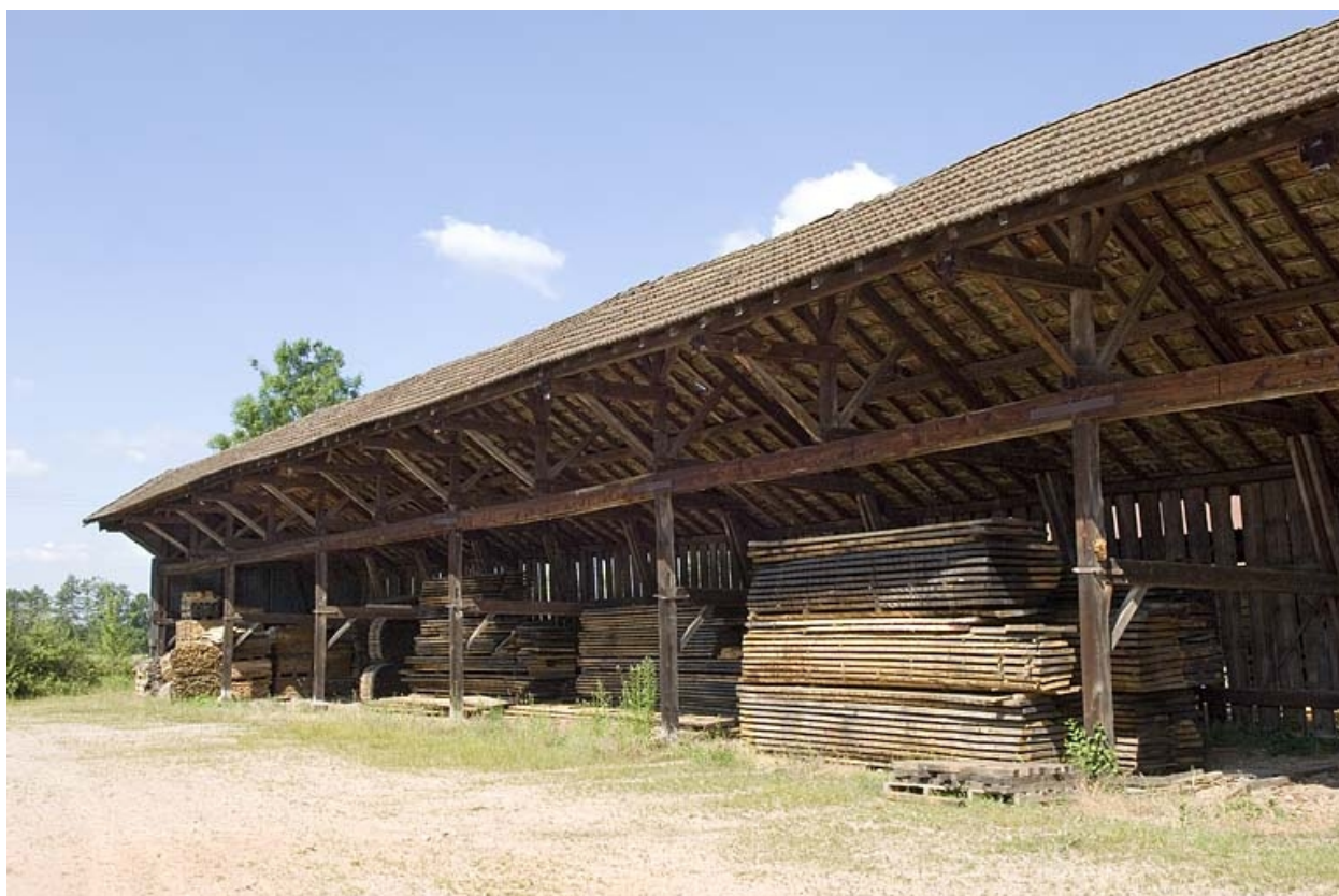
Entrepôt industriel ouest. Vue de trois quarts.
