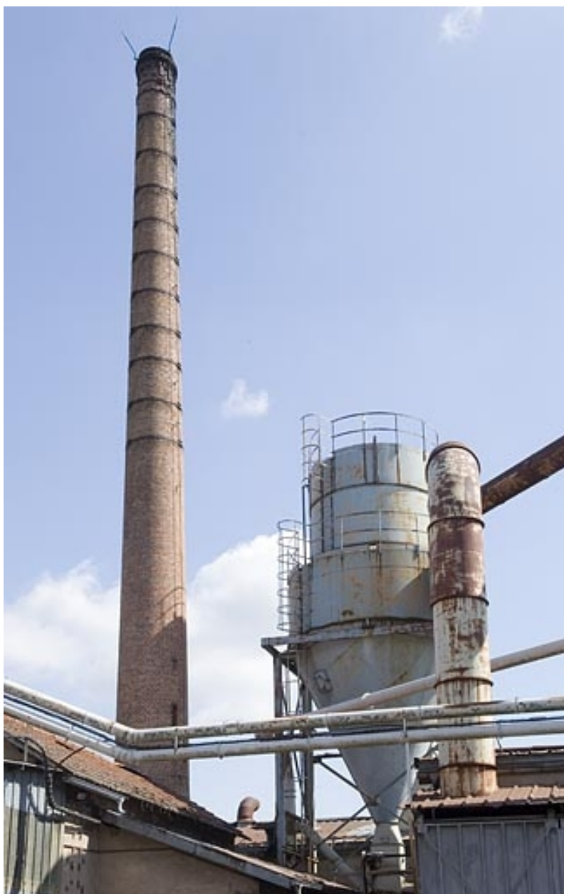
Cheminée et silo. Vue rapprochée.
