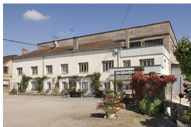
Conciergerie et bureaux. Phot. Jérôme Mongreville IVR43_20097000408NUC2A
