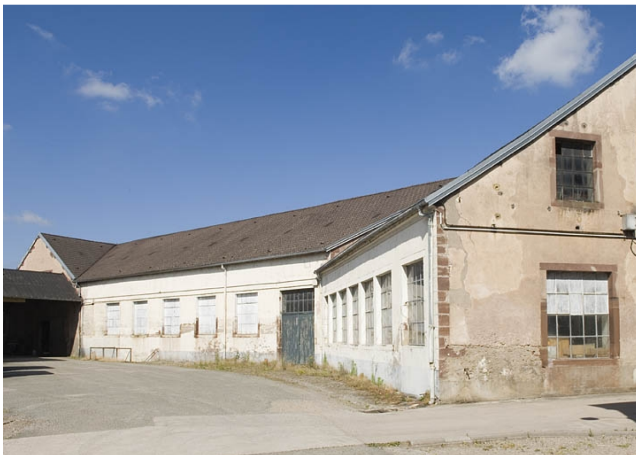
Atelier de fabrication originel. Vue depuis l'est.
