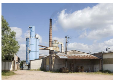
Silo et cheminée. Vue d'ensemble. Phot. Jérôme Mongreville IVR43_20097000423NUC2A
