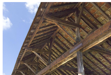
Entrepôt industriel ouest. Détail de la charpente. Phot. Jérôme Mongreville IVR43_20097000419NUC2A
