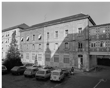
Bâtiment annexe (Pavillon nord) depuis la cour. Phot. Yves Sancey IVR43_19833900617X
