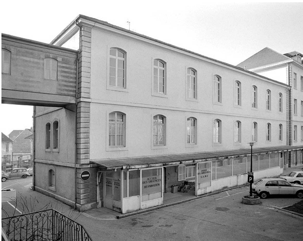
Bâtiment annexe (Pavillon sud) depuis la cour.
