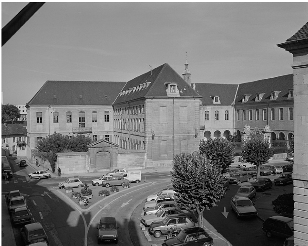
Vue de la partie gauche de l'édifice.
