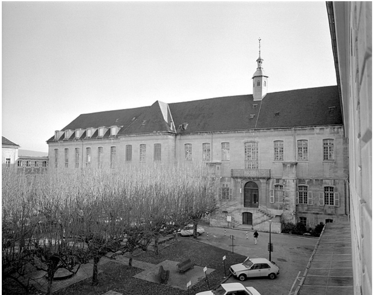
Façade postérieure, vue partielle.
