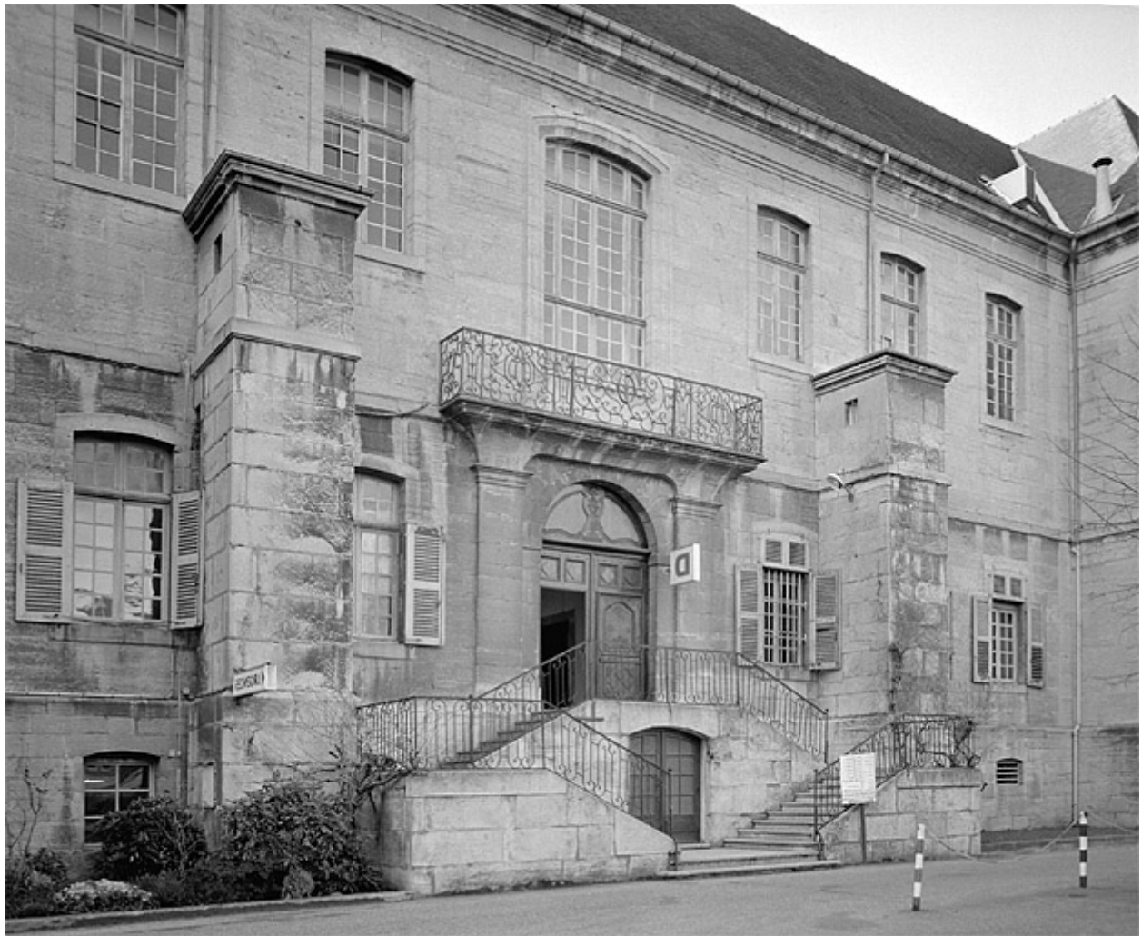
Façade postérieure, escalier extérieur.
