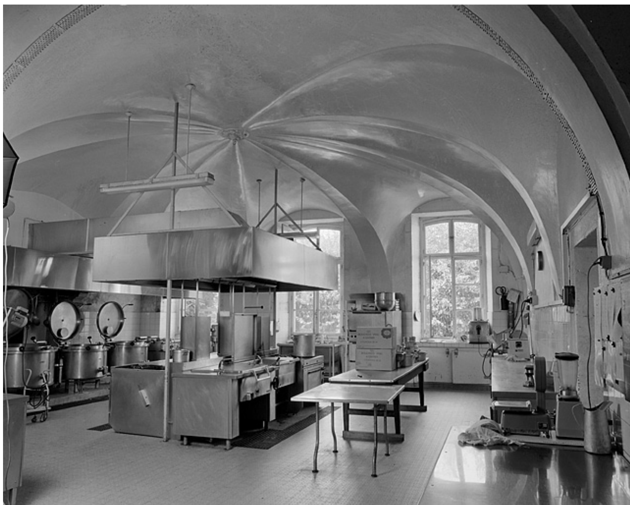
Cuisines : vue d'ensemble.
