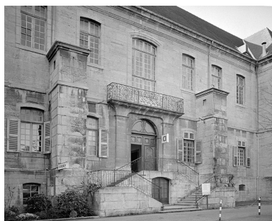
Façade postérieure, escalier extérieur. Phot. Yves Sancey IVR43_19833900614X
