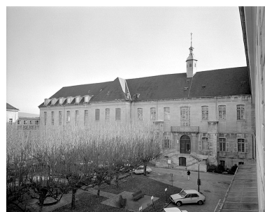
Façade postérieure, vue partielle. Phot. Yves Sancey IVR43_19833900613X
