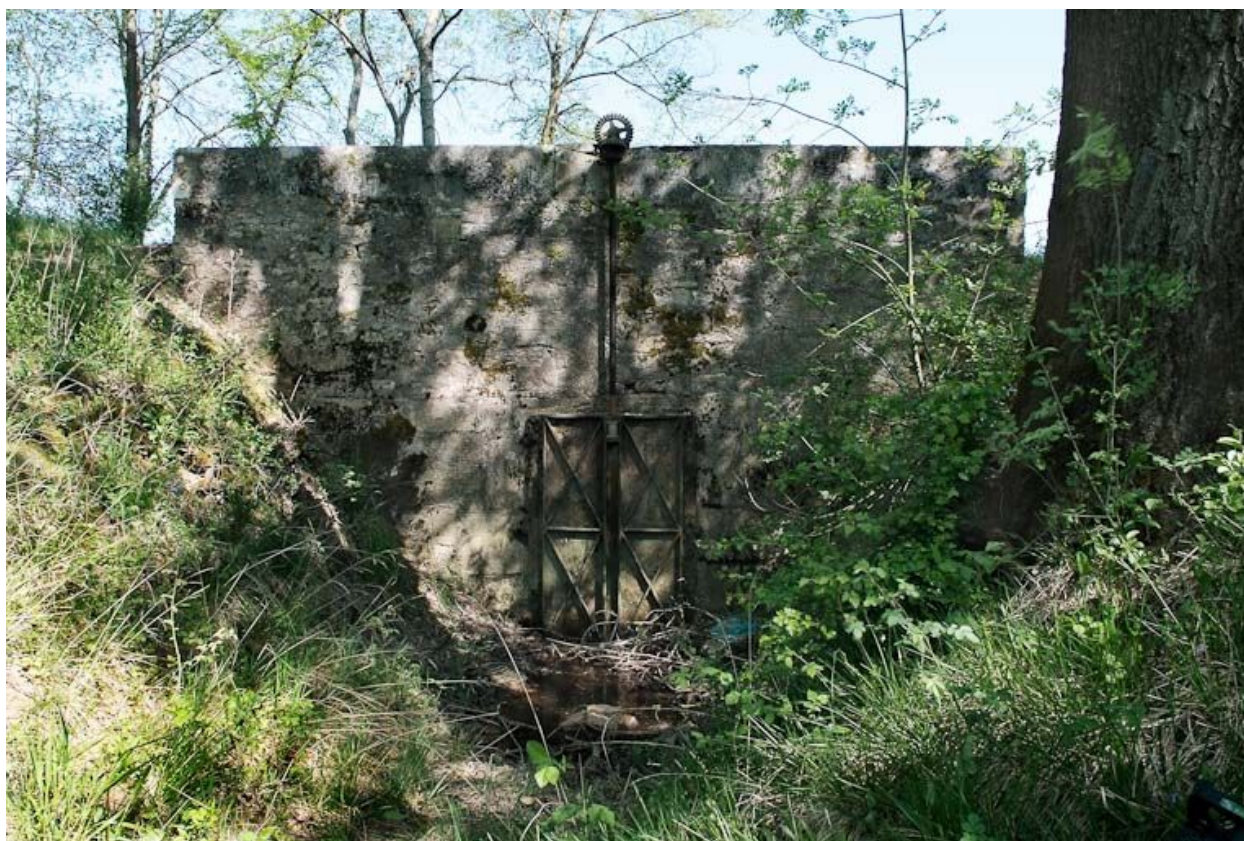
Vanne de l'aqueduc.
