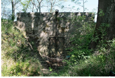
Vanne de l'aqueduc. Phot. Jean-Luc Duthu IVR26_20107100520NUC2A
