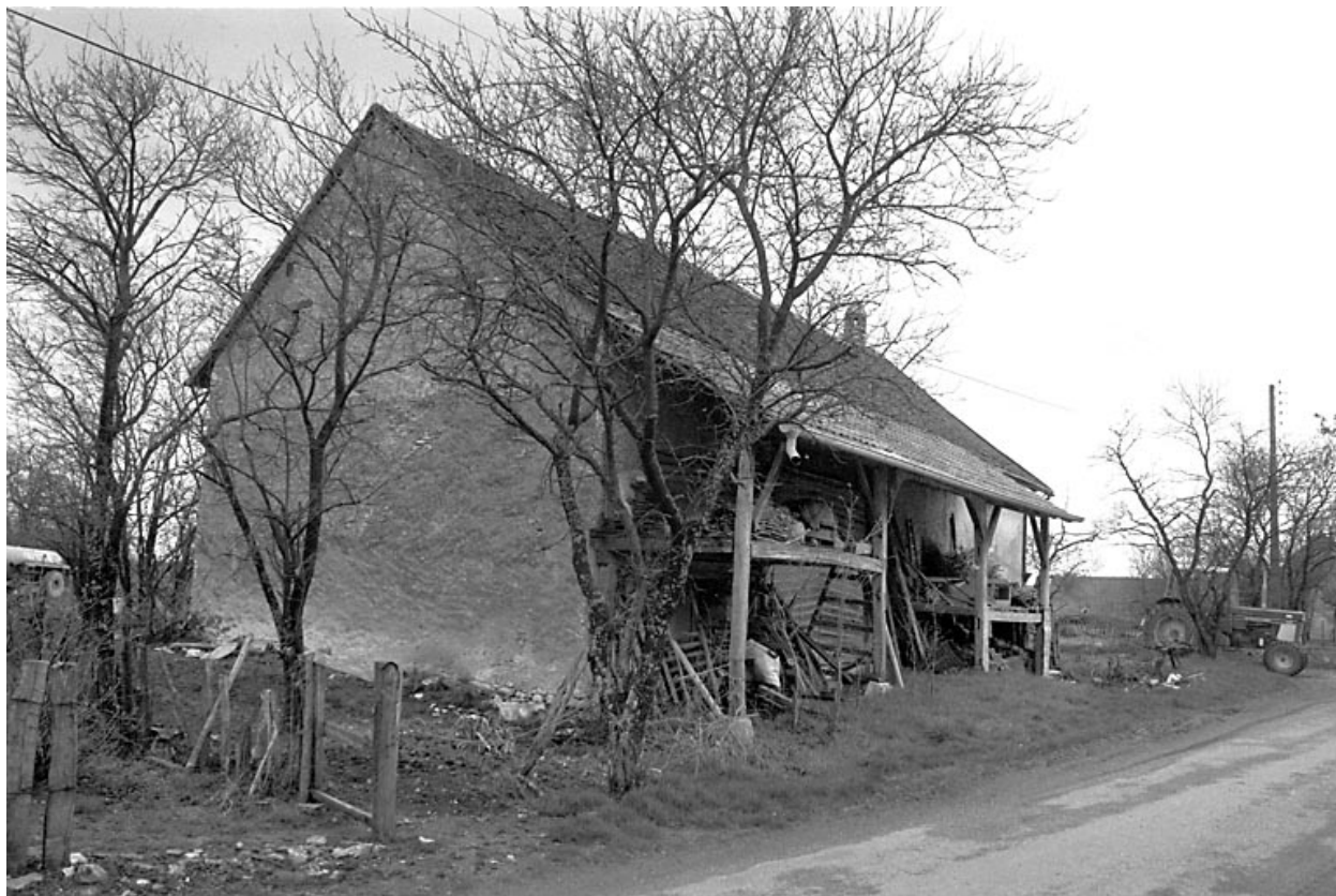
Vue d'ensemble de la façade antérieure.
