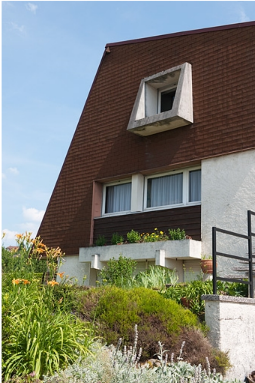
Détail : baies de la façade antérieure.
