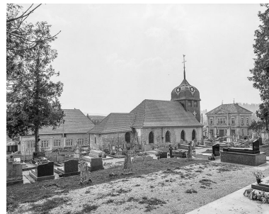
Vue d'ensemble depuis le cimetière. Phot. Yves Sancey IVR43_19812500094X
