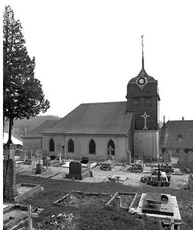
Vue de la façade latérale nord. Phot. Yves Sancey IVR43_19812500095X
