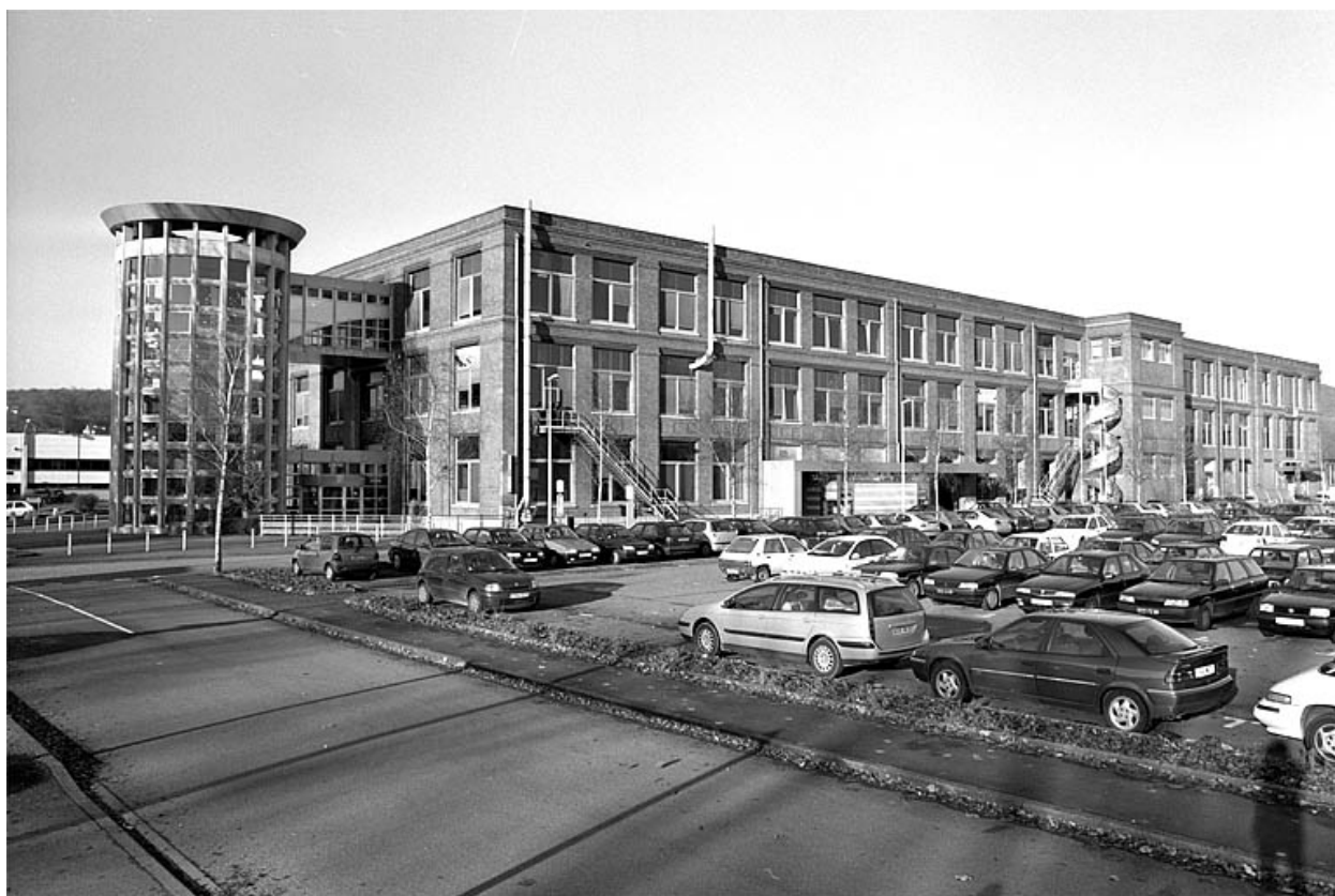
Extension de l'atelier de retordage depuis l'est.
