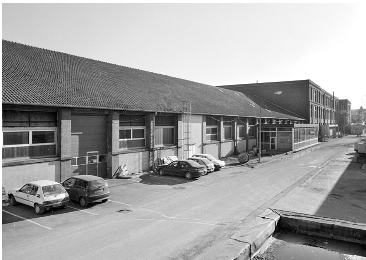
Atelier de retordage : façade ouest à mi-parcours.
