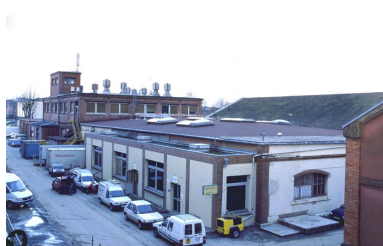
Atelier de blanchiment : vue de trois quarts arrière. Phot. Jérôme Mongreville IVR43_20019000664ZA
