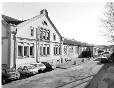
Bâtiment des bureaux et des magasins : façade ouest. Phot. Jérôme Mongreville IVR43_20019000645X
