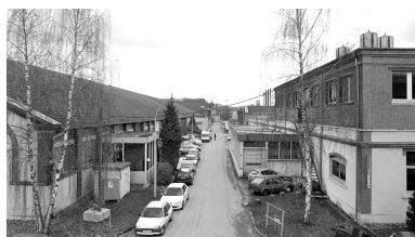
Allée située entre l'atelier de retordage et celui de blanchiment : vue depuis le nord. Phot. Jérôme Mongreville IVR43_20019000673X
