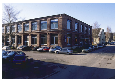
Atelier de finissage et atelier de retordage : vue de trois quarts gauche. Phot. Jérôme Mongreville IVR43_20019000671ZA
