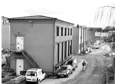
Transformateur : vue depuis l'atelier de filature. Phot. Jérôme Mongreville IVR43_20019000678X
