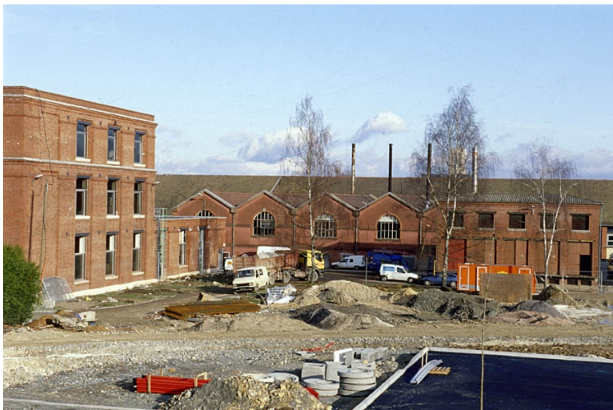
Atelier de filature, chaufferie et transformateur : vue depuis l'ouest.
