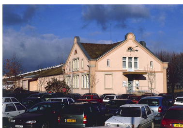
Bâtiment des magasins et des bureaux : vue de trois quarts. Phot. Jérôme Mongreville IVR43_20019000650ZA
