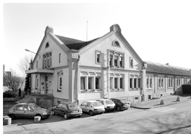
Bureaux situés à l'extrémité sud du bâtiment des magasins : vue de trois quarts droite. Phot. Jérôme Mongreville IVR43_20019000648X
