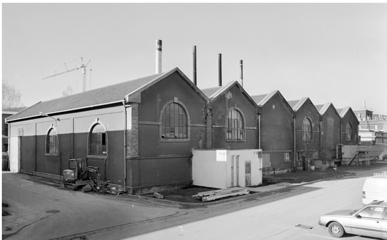
Chaufferie : vue depuis le sud-est.
