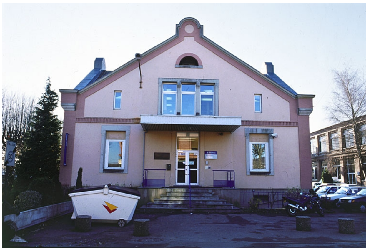
Bureaux situés à l'extrémité nord du bâtiment des magasins.
