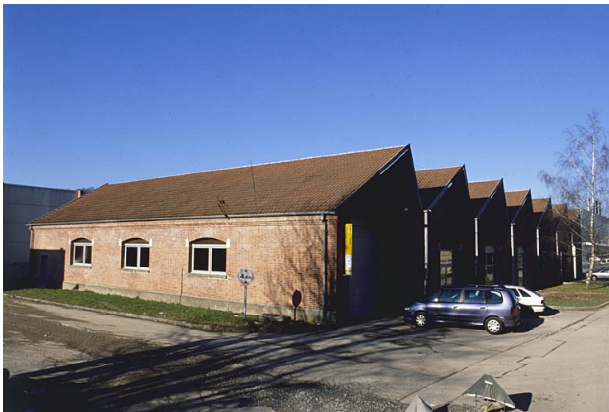
Atelier de teinturerie : vue depuis le sud-est.
