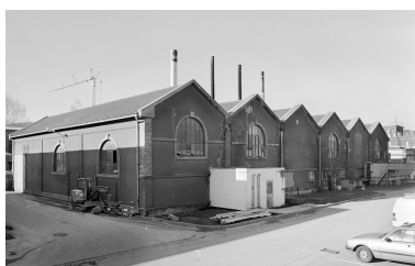
Chaufferie : vue depuis le sud-est. Phot. Jérôme Mongreville IVR43_20019000694X
