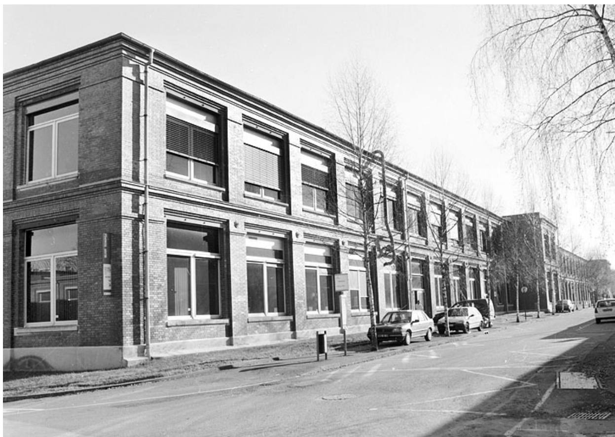
Atelier de finissage : façade ouest.
