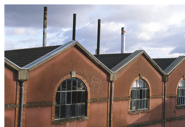
Chaufferie : façade ouest. Phot. Jérôme Mongreville IVR43_20019000702ZA
