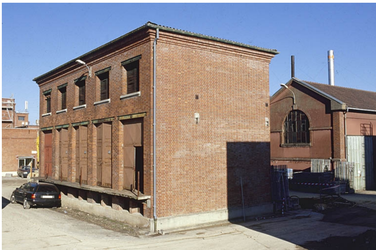
Transformateur : vue depuis le sud-ouest.
