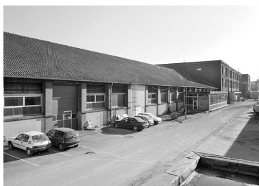
Atelier de retordage : façade ouest à mi-parcours. Phot. Jérôme Mongreville IVR43_20019000692X
