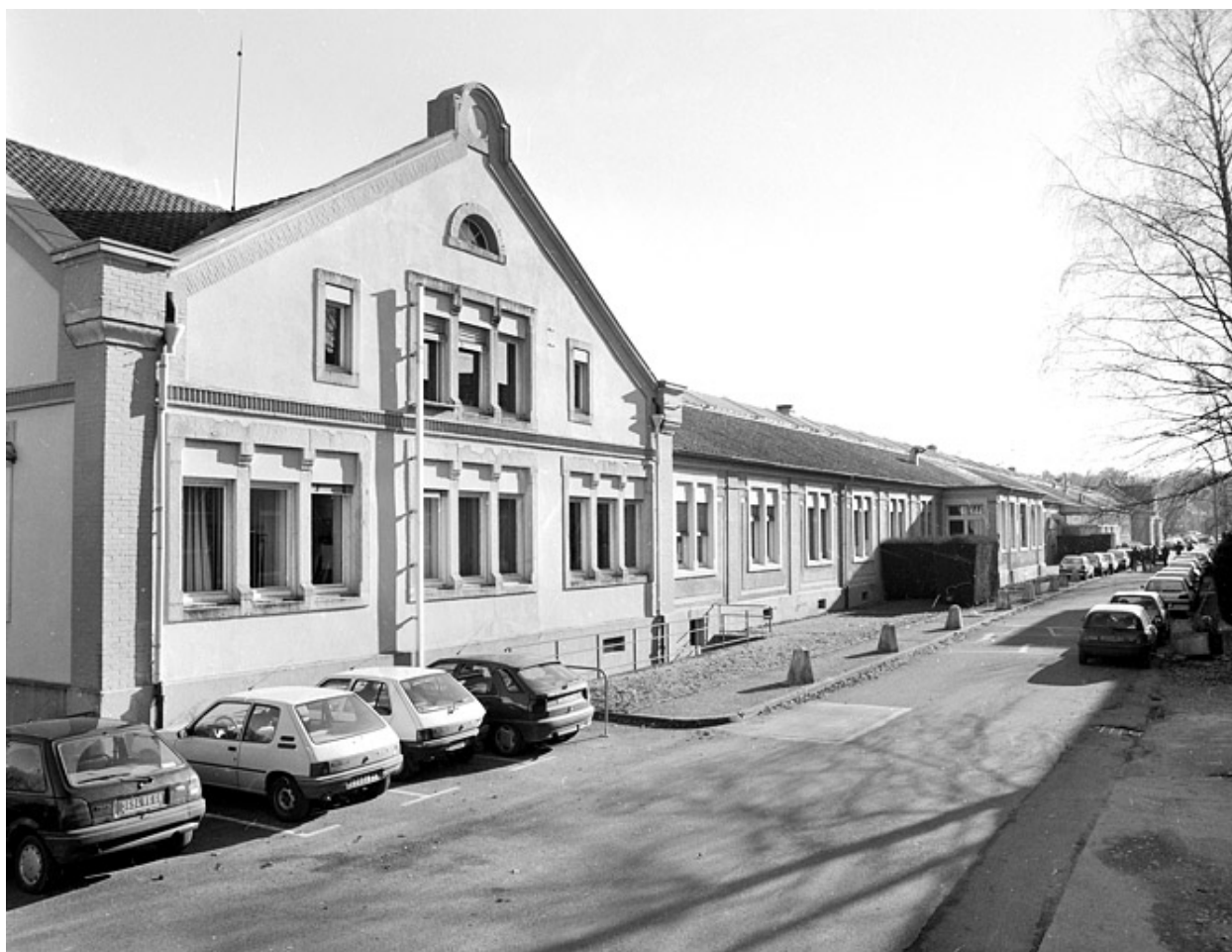
Bâtiment des bureaux et des magasins : façade ouest.
