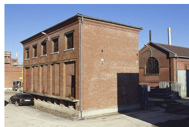
Transformateur : vue depuis le sud-ouest. Phot. Jérôme Mongreville IVR43_20019000684ZA
