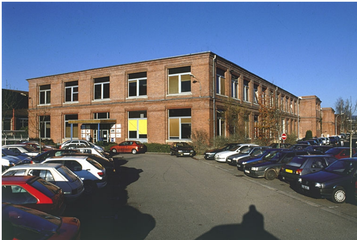
Atelier de finissage : extrémité sud.
