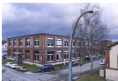
Atelier de finissage : extrémité nord vue de trois quarts. Phot. Jérôme Mongreville IVR43_20019000666ZA
