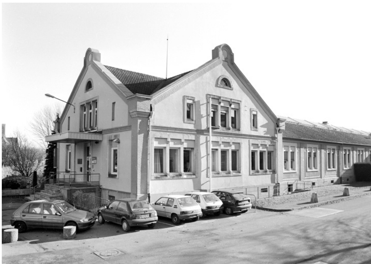
Bureaux situés à l'extrémité sud du bâtiment des magasins : vue de trois quarts droite.
