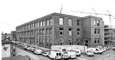
Atelier de filature : vue de trois quarts gauche. Phot. Jérôme Mongreville IVR43_20019000677X
