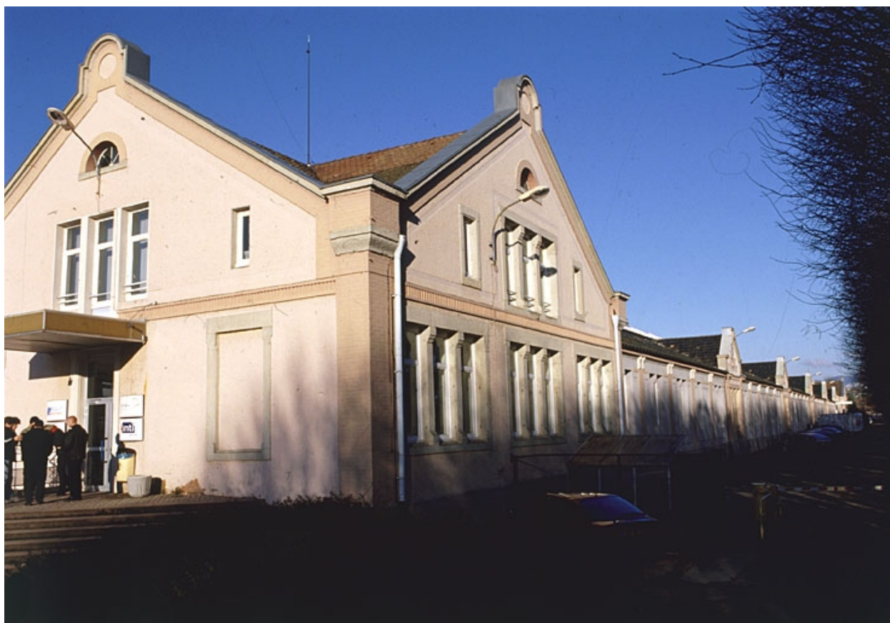
Bâtiment des bureaux et des magasins : façade est.
