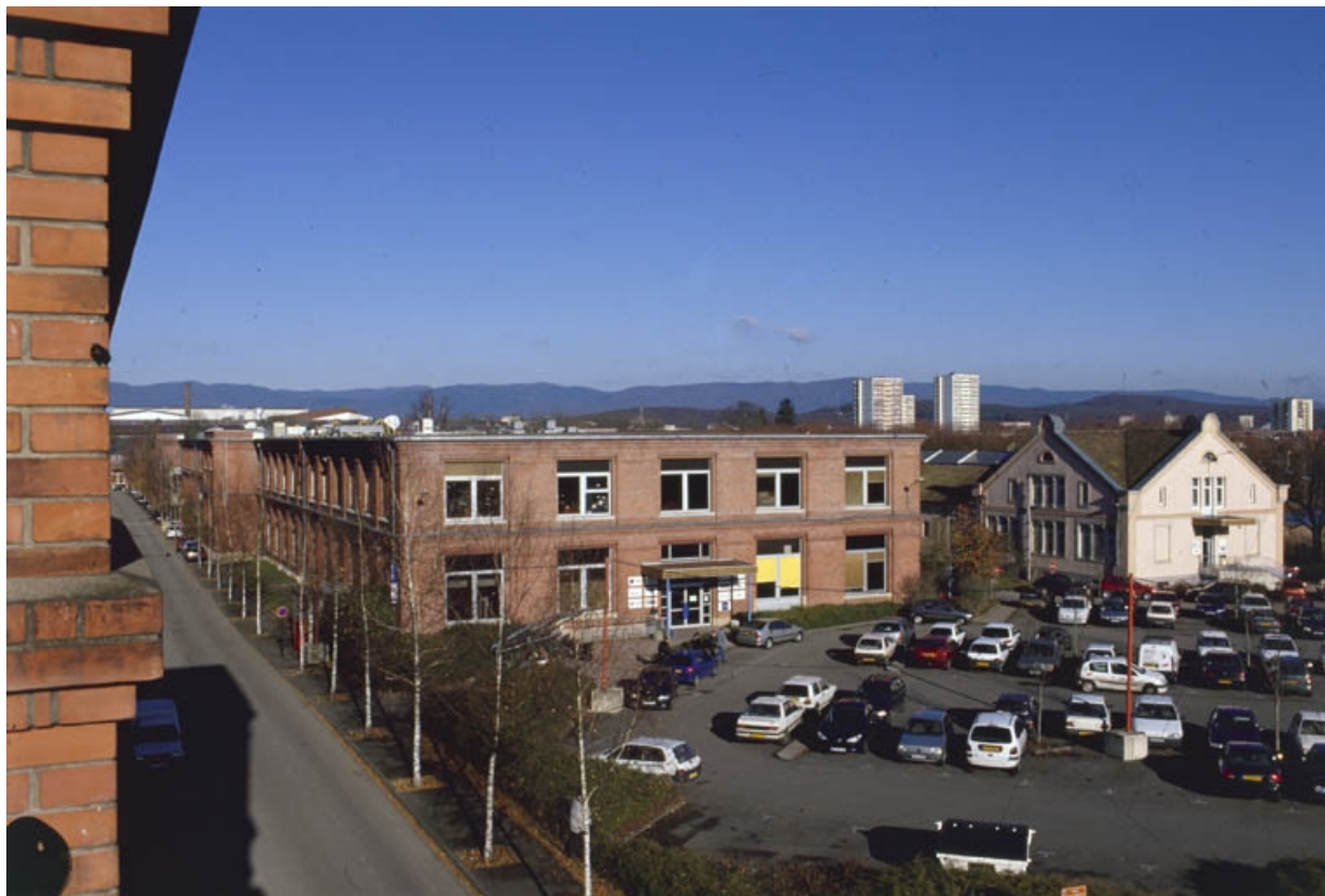
Atelier de finissage et bâtiment des magasins et des bureaux : vue depuis le sud-ouest.
