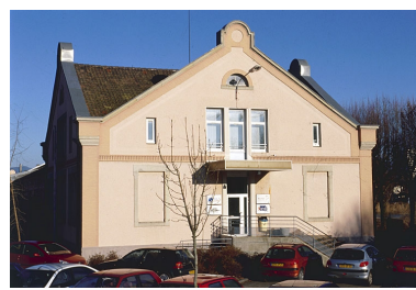
Bureaux situés à l'extrémité sud du bâtiment des magasins. Phot. Jérôme Mongreville IVR43_20019000638ZA
