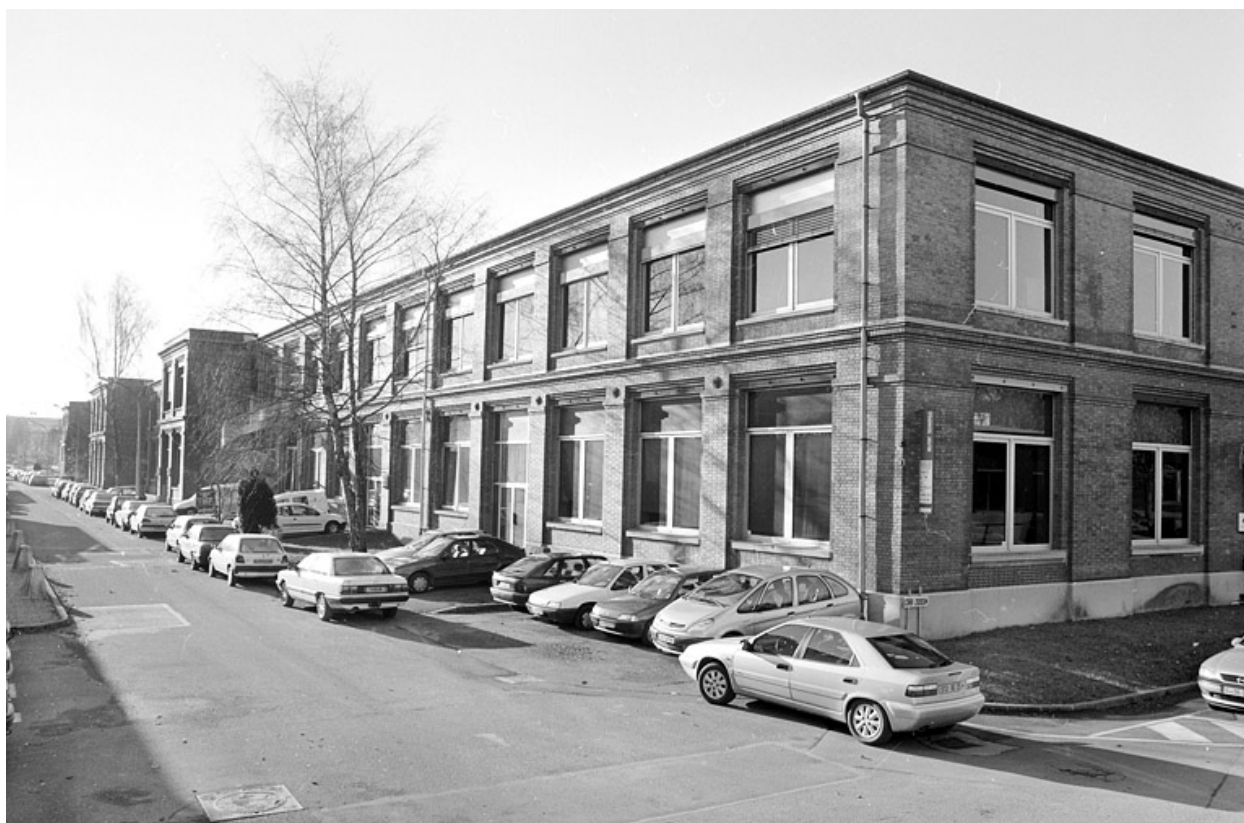
Atelier de finissage : façade est.
