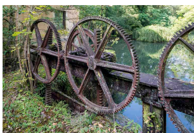
Vannage du canal d'amenée. Détail du mécanisme de levage. Phot. Jérôme Mongreville IVR43_20172501081NUC4A
