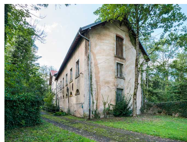
Vue de trois quarts depuis l'entrée. Phot. Jérôme Mongreville IVR43_20172501070NUC4A
