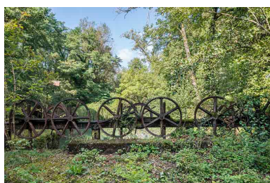
Mécanisme de levage du vannage (canal d'amenée). Phot. Jérôme Mongreville IVR43_20172501080NUC4A
