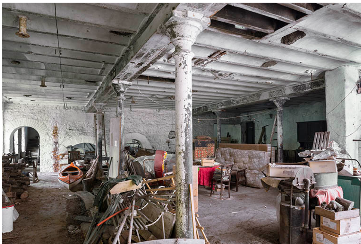
Atelier de fabrication. Vue du rez-de-chaussée.
