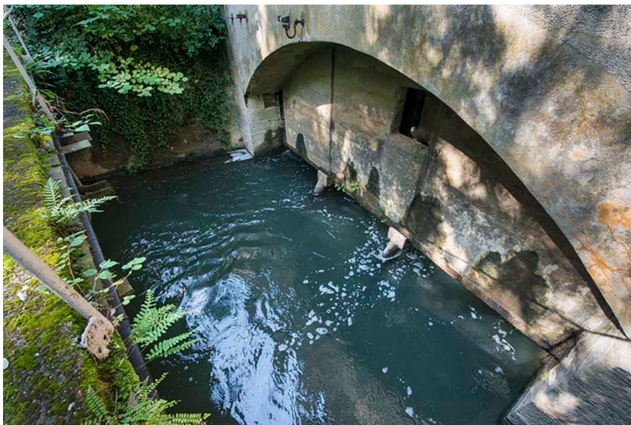
Canal de fuite en sortie de l'atelier.
