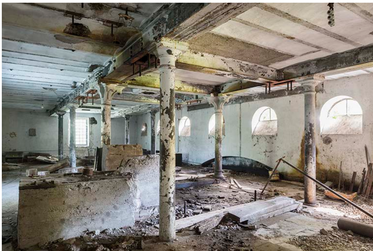
Atelier de fabrication (rez-de-chaussée). Partie est.
