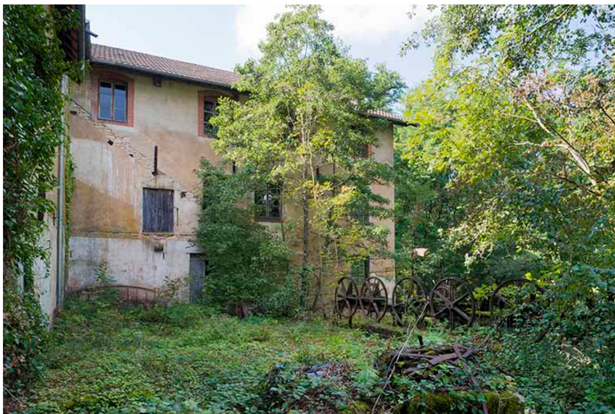
Façade postérieure de l'atelier de fabrication.
