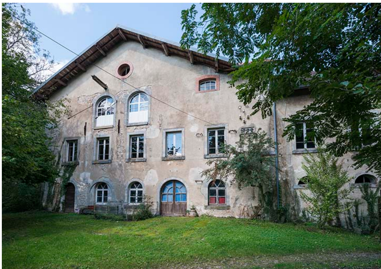
Façade antérieure de l'atelier de fabrication.
