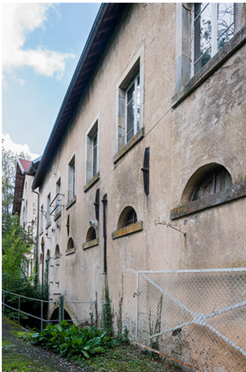
Façade antérieure. Vue depuis l'entrée.
