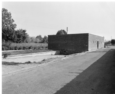
Lavoir et abreuvoir. Phot. non renseigné IVR26_19728900183X
