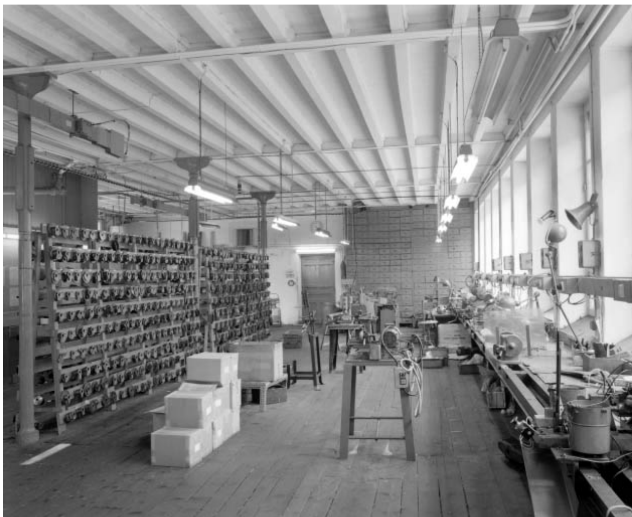
Entrepôt au 1er étage du bâtiment de 1902.
