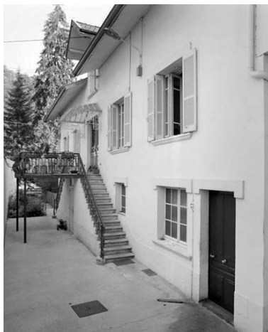
Façade sur cour du bâtiment de 1927. Phot. Jérôme Mongreville IVR43_19923900500X
