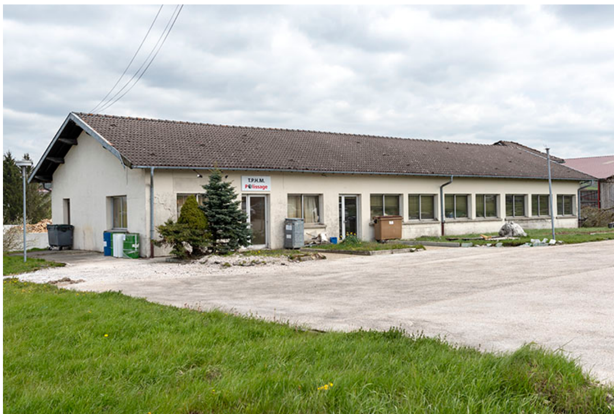
Façades antérieure et latérale gauche.
