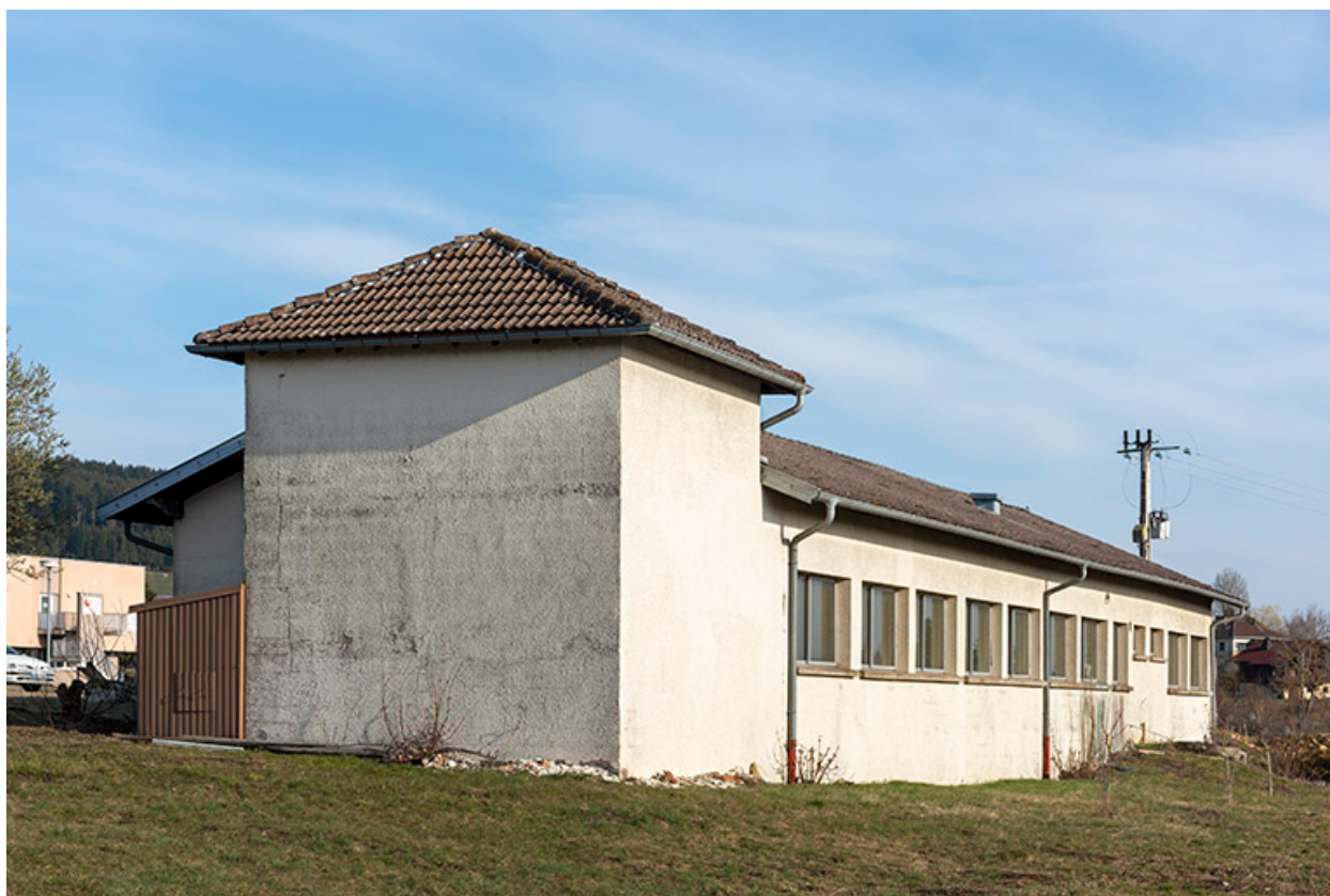
Façades postérieure et latérale gauche.
