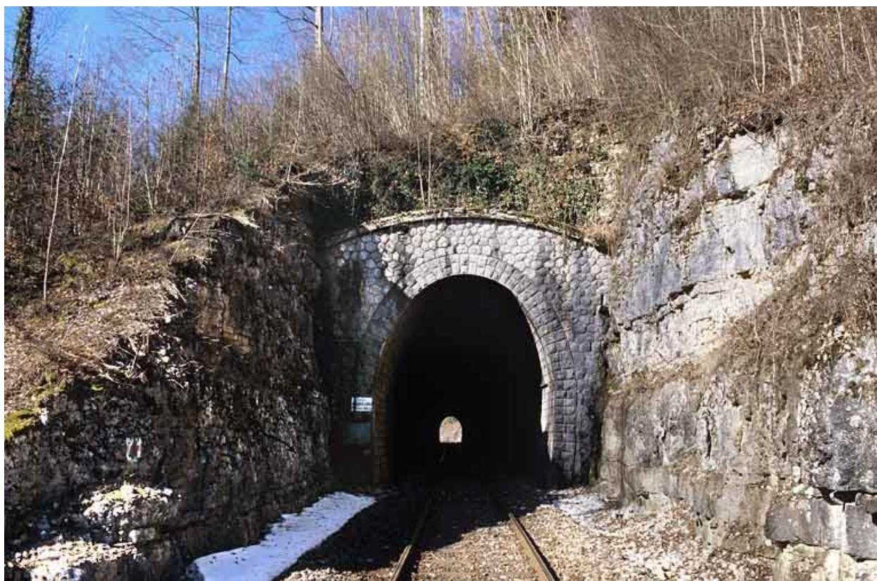
Tunnel des Bataillards : tête côté Andelot-en-Montagne (est).
