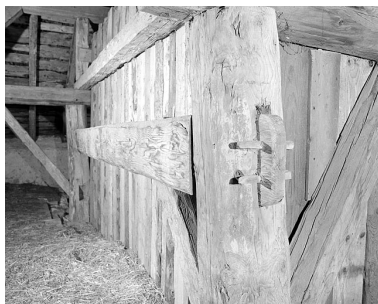
Assemblage de la charpente dans les combles. Phot. Jérôme Mongreville IVR43_19963901496X
