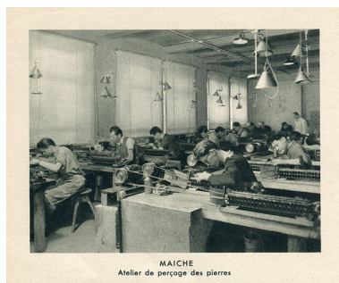
Maîche. Atelier de perçage des pierres, 1950. Autr. auteur inconnu IVR43_20182501473NUC4A
