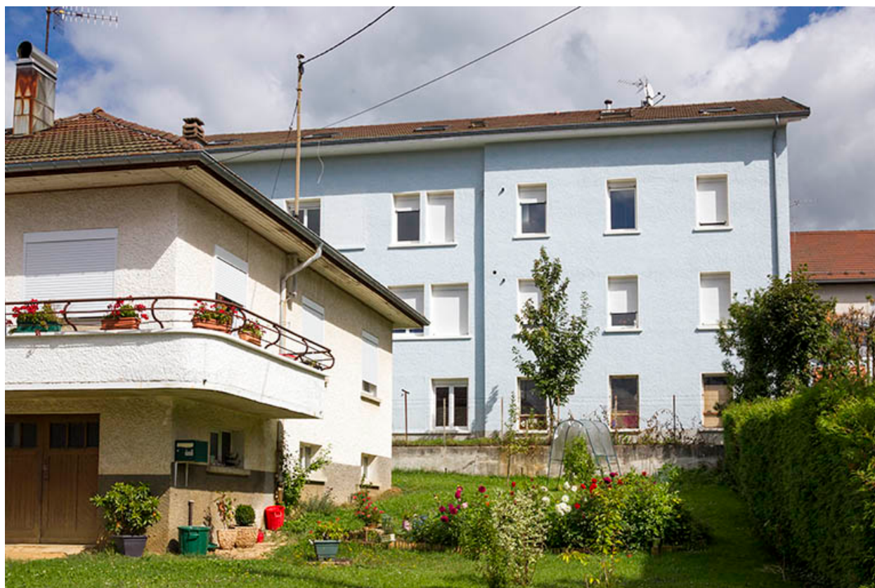
Façade postérieure (partie droite).
