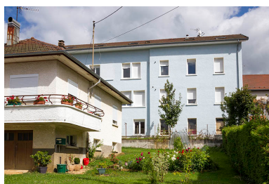
Façade postérieure (partie droite).
