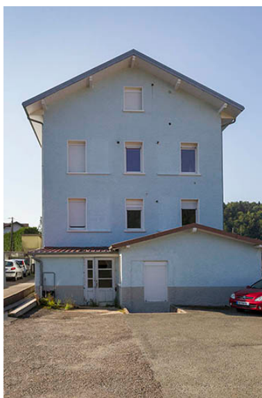
Façade latérale droite.
