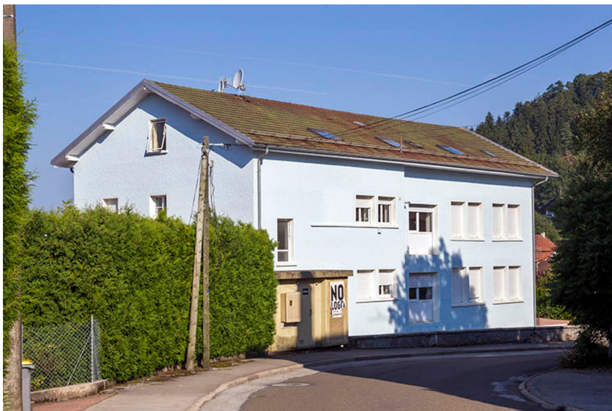
Vue d'ensemble, de trois quarts gauche (façades antérieure et latérale gauche).
