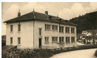
Maîche - Colonie Peugeot [façade antérieure], décennie 1930. Autr. E. Voide IVR43_20152502060NUC4A
