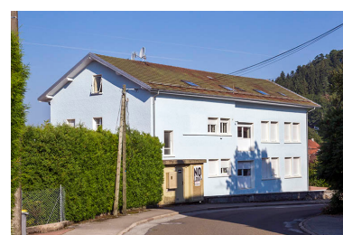
Vue d'ensemble, de trois quarts gauche (façades antérieure et latérale gauche). Phot. Yves Sancey IVR43_20132501767NUC2A
