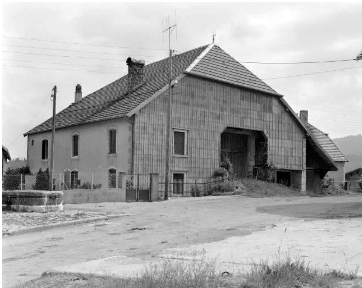
Façades antérieure et latérale droite.
