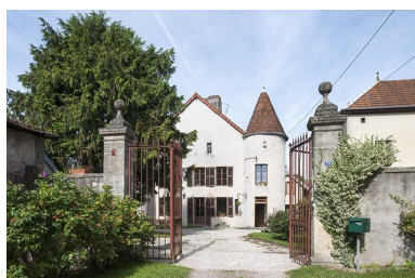
Vue rapprochée depuis la Grande Rue. Phot. Jérôme Mongreville IVR43_20127000662NUC4A
