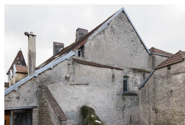
Façade postérieure côté rue Catinat. Phot. Jérôme Mongreville IVR43_20137000087NUC4A
