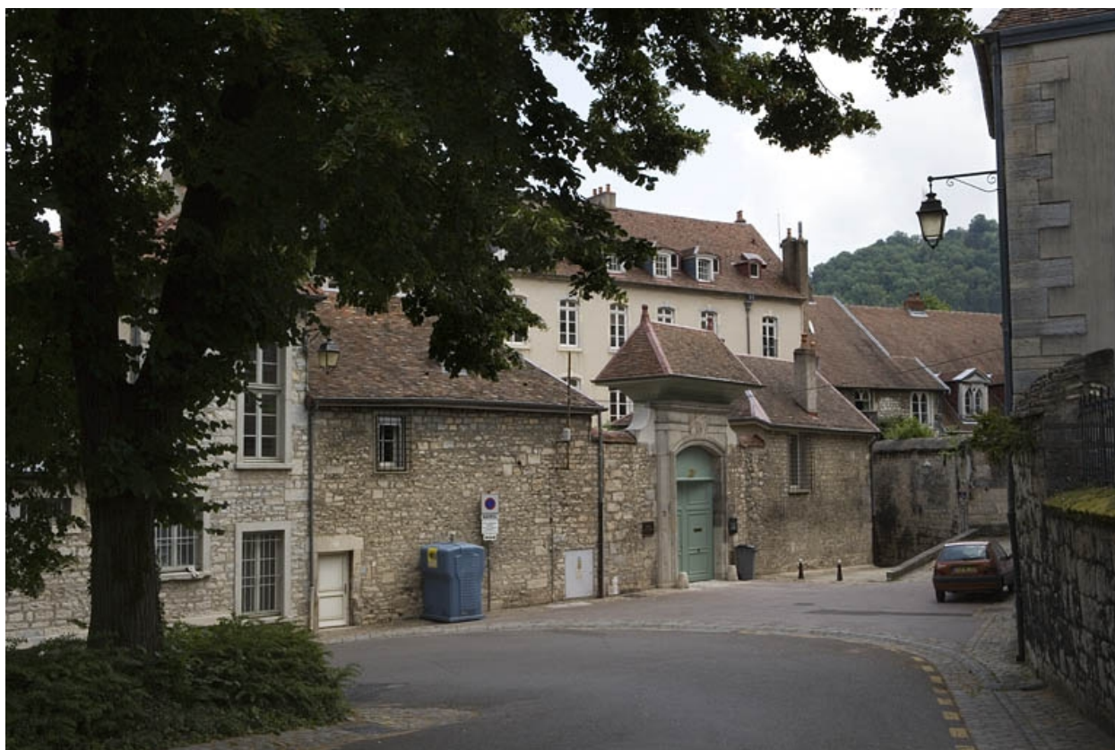
Vue d'ensemble du portail d'entrée depuis l'extérieur.
