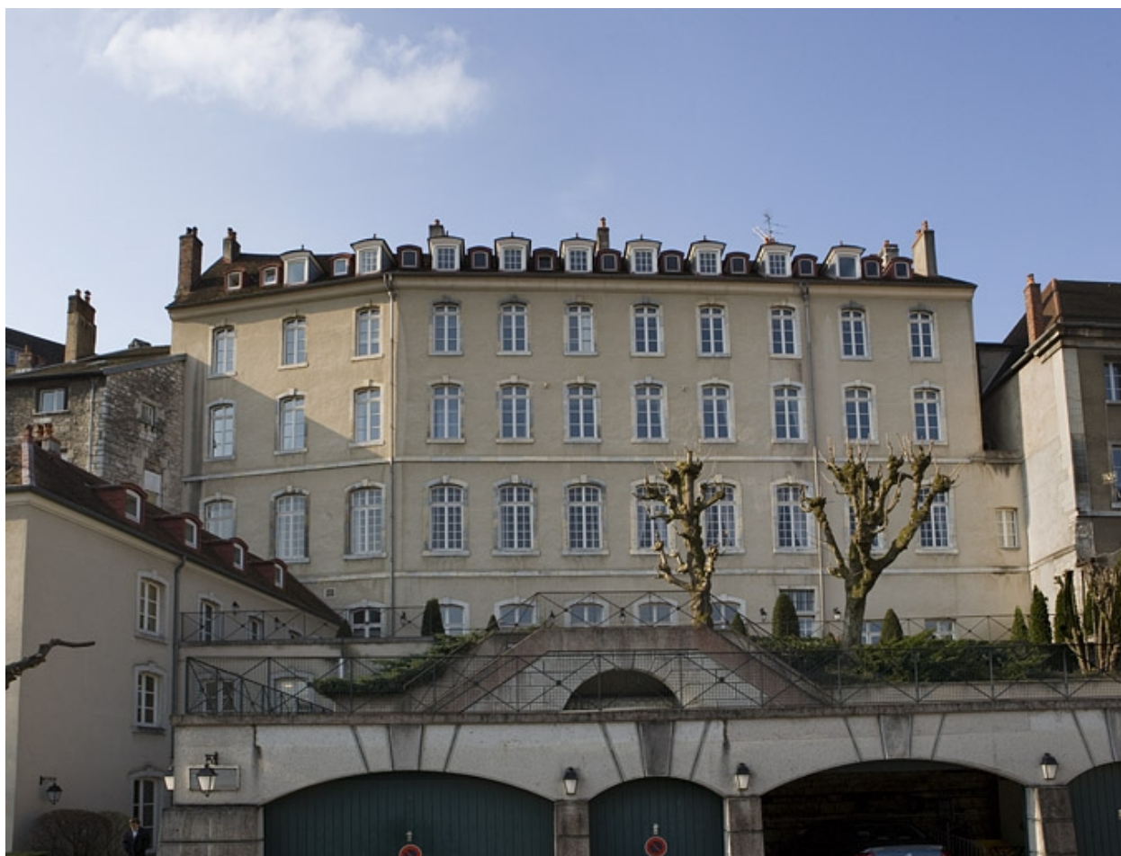
Vue d'ensemble de la façade postérieure.
