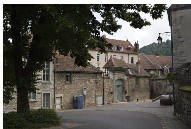
Vue d'ensemble du portail d'entrée depuis l'extérieur.
