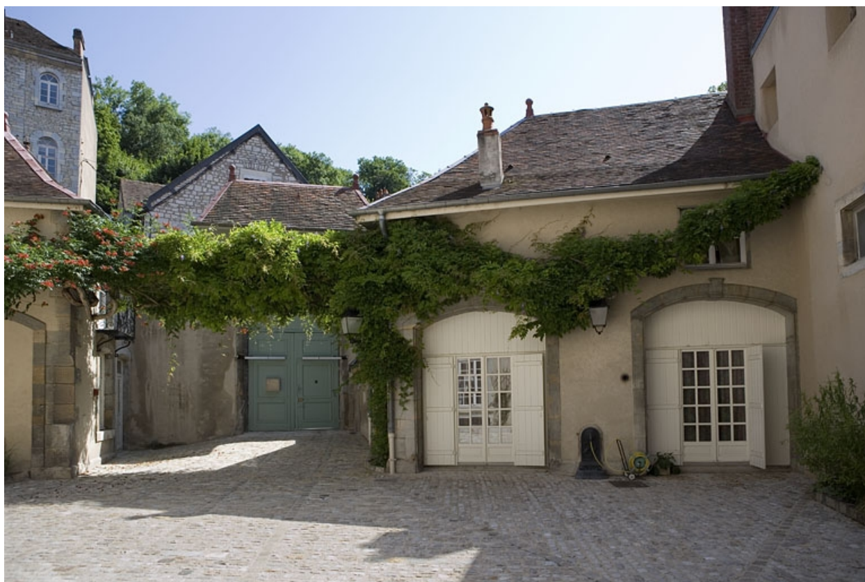
Détail des communs, partie droite de face.
