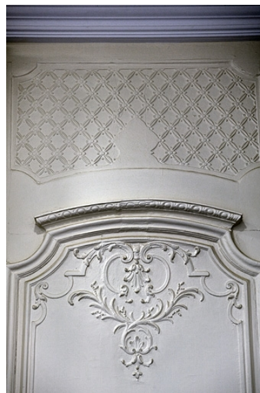
Intérieur : détail d'un lambris d'un ancien cabinet.
