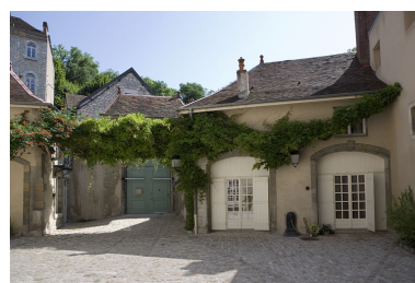
Détail des communs, partie droite de face.
