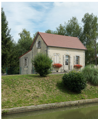
Vue rapprochée de la maison éclusière.
