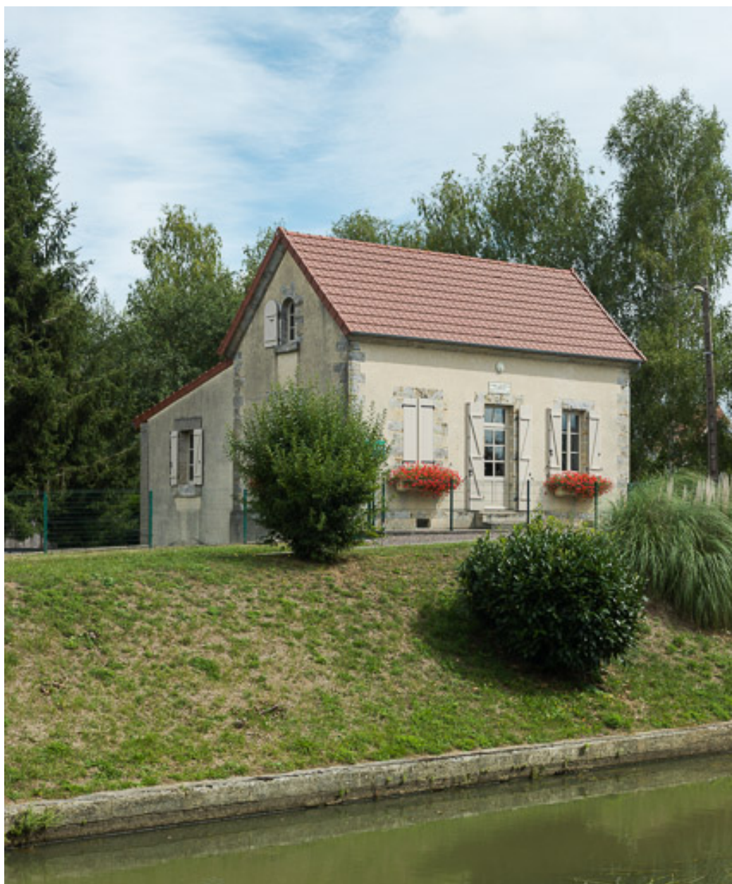
Vue rapprochée de la maison éclusière.
