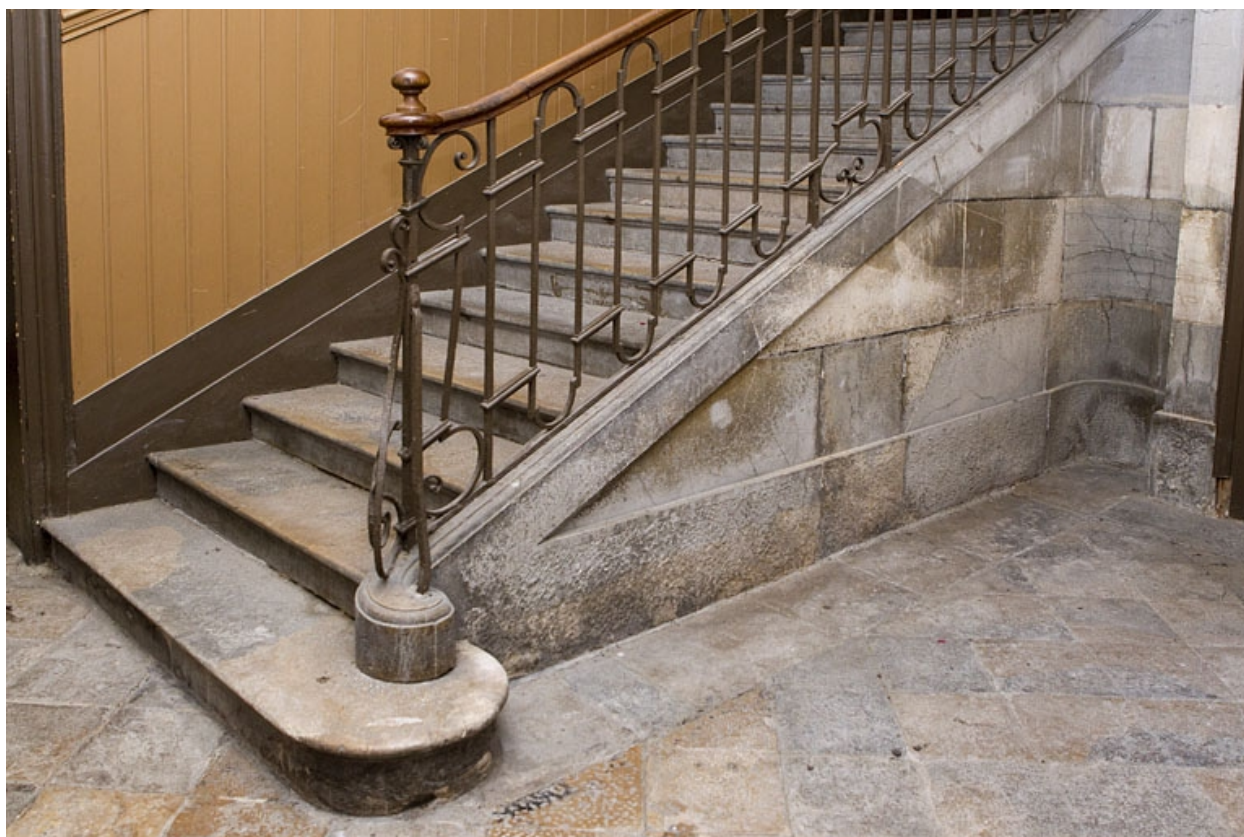
Détail du départ de l'escalier.
