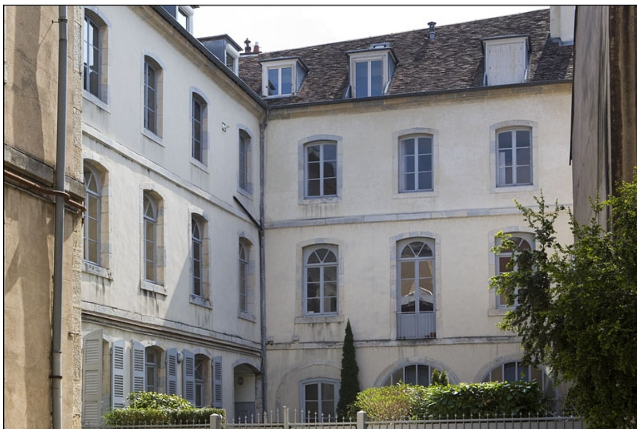
Vue d'ensemble du logis secondaire.
