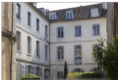
Vue d'ensemble du logis secondaire.
