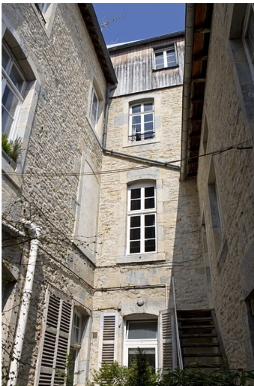
Vue des façades donnant sur l'ancienne basse-cour.
