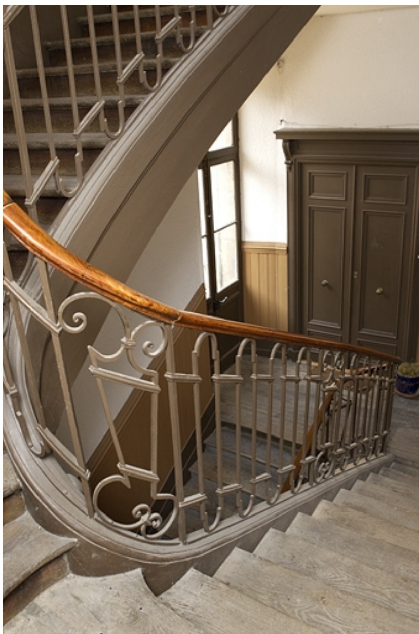
Vue de l'intérieur de l'escalier.
