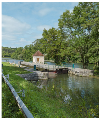
Vue du site d'écluse.
