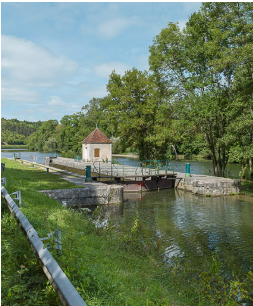
Vue du site d'écluse.
