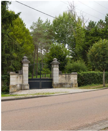
Portail d'entrée du château. Phot. Pierre-Marie Barbe-Richaud IVR26_20178900010NUC2A
