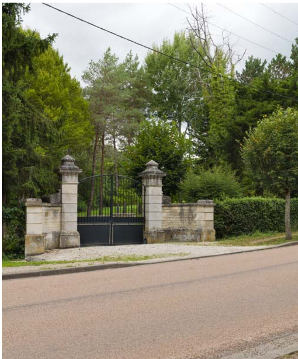
Portail d'entrée du château.
