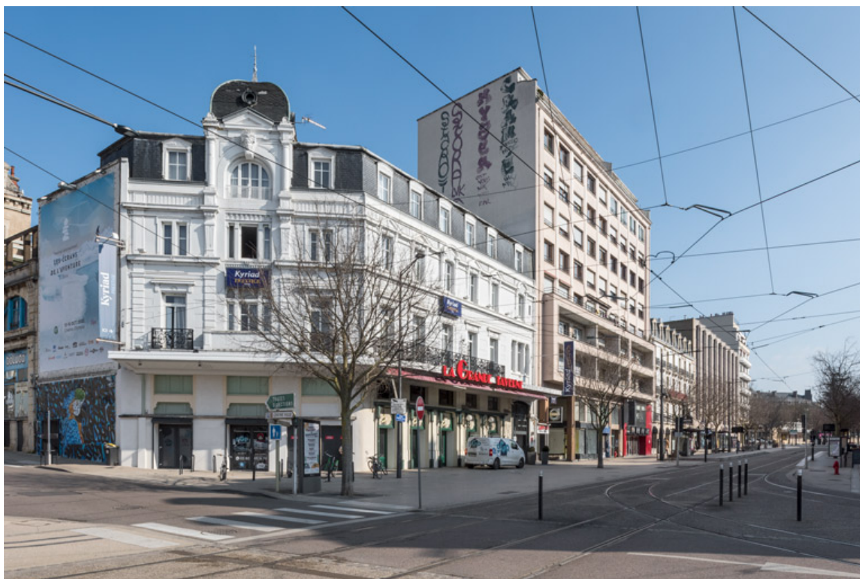
Ancienne Grande Taverne et immeuble rue Maréchal Foch.
