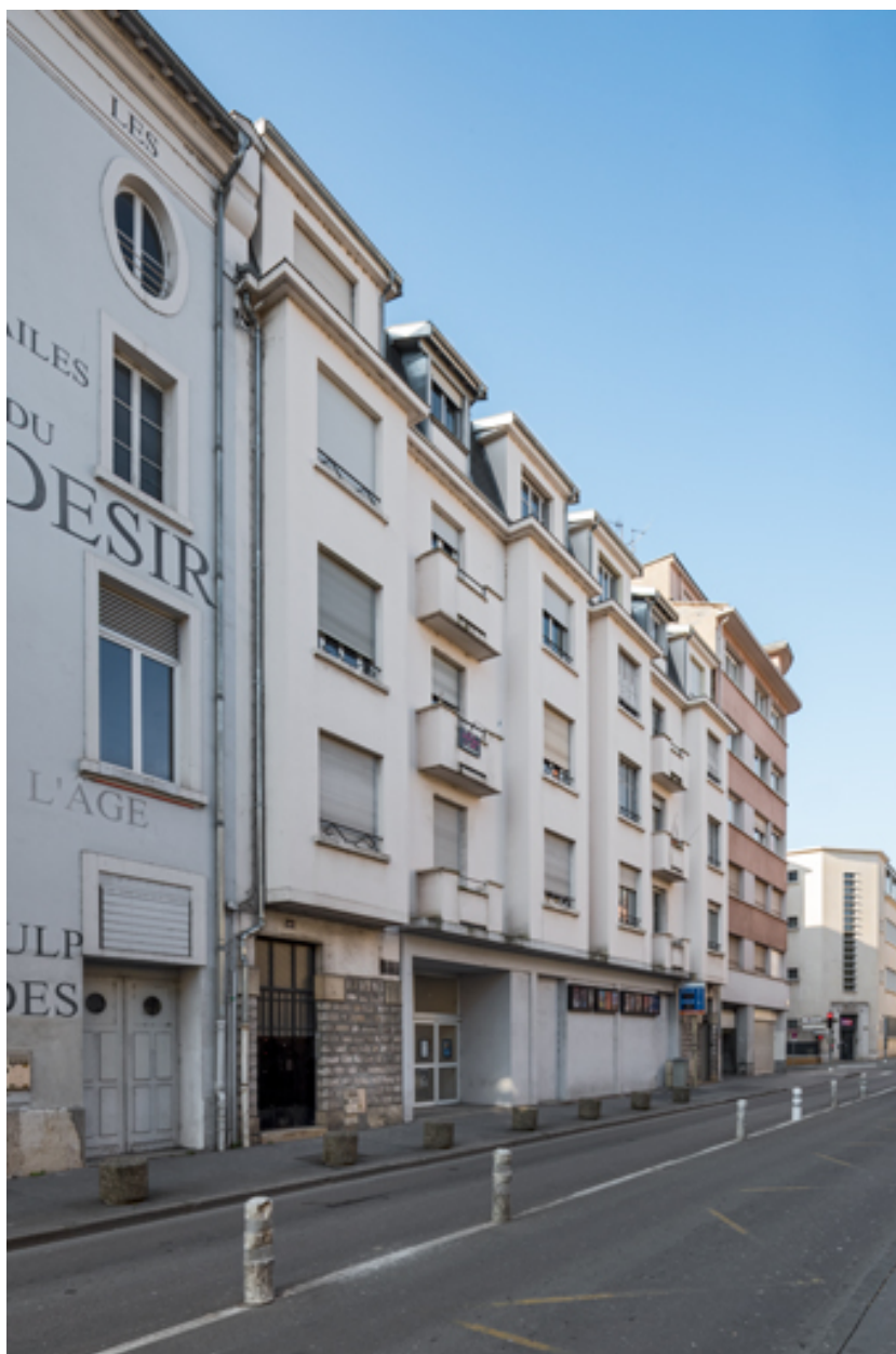
Immeuble rue des Perrières : salles 9 et 10.
