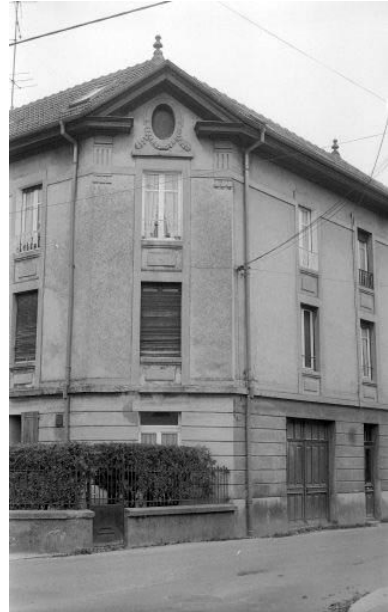
élévation : détail. Phot. Bernard Lardière IVR43_19832500191Z
