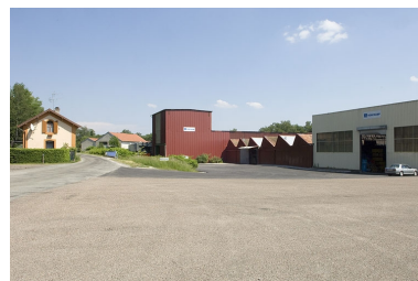
Ateliers de fabrication nord. Phot. Jérôme Mongreville IVR43_20067000520NUCA
