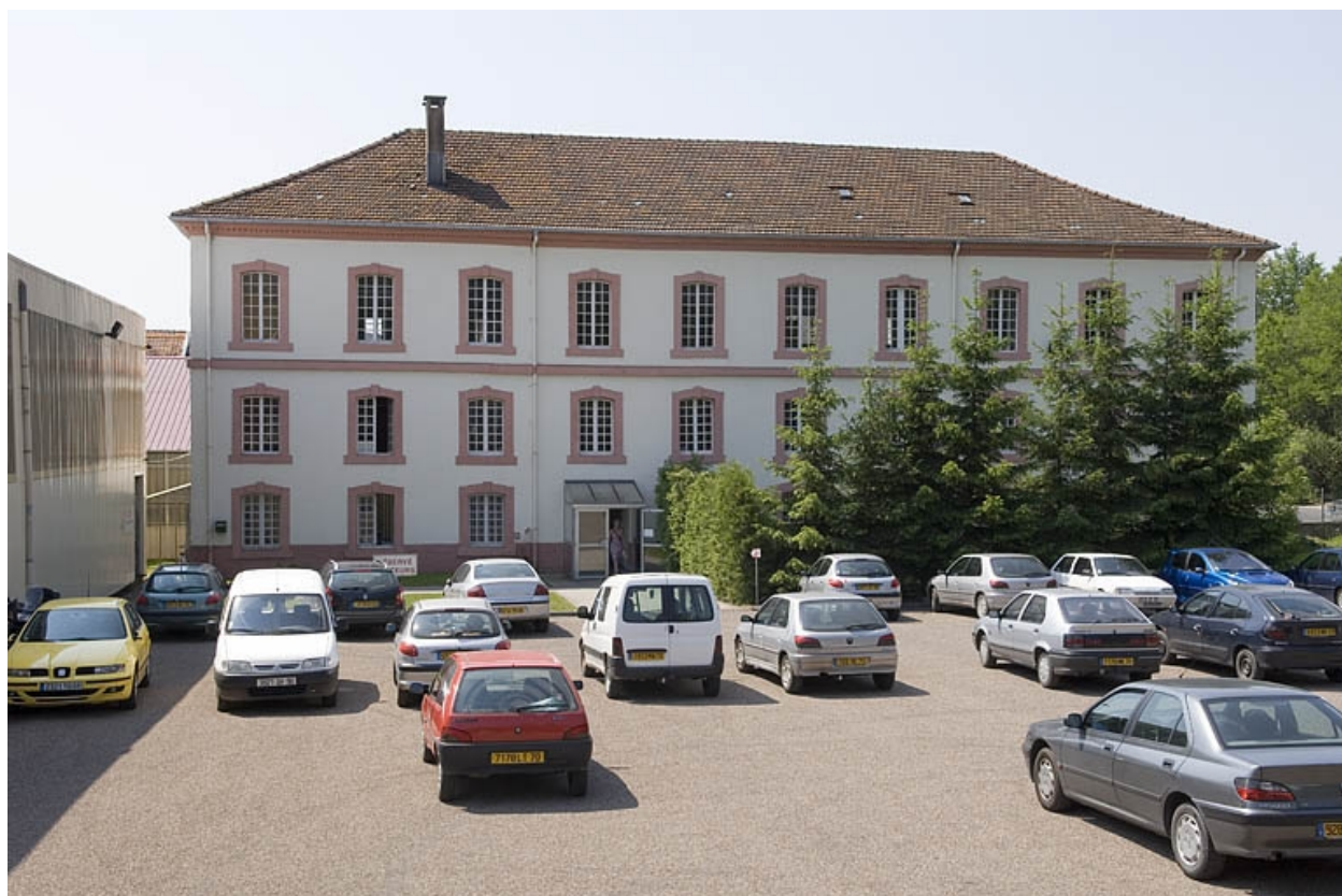
Immeuble de bureaux.
