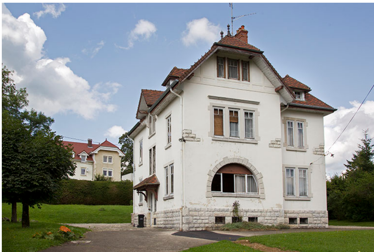
Façades antérieure et latérale gauche.
