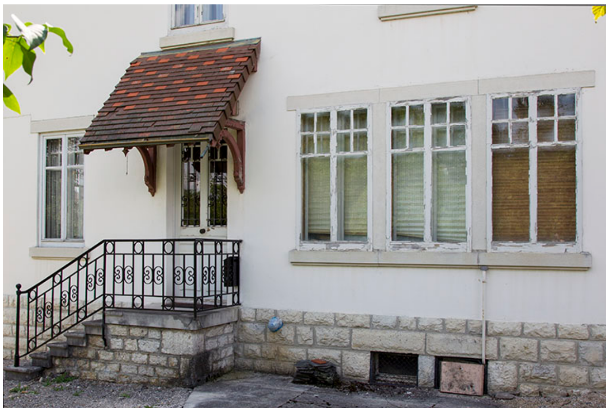
Façade latérale droite : entrée et fenêtres multiples.
