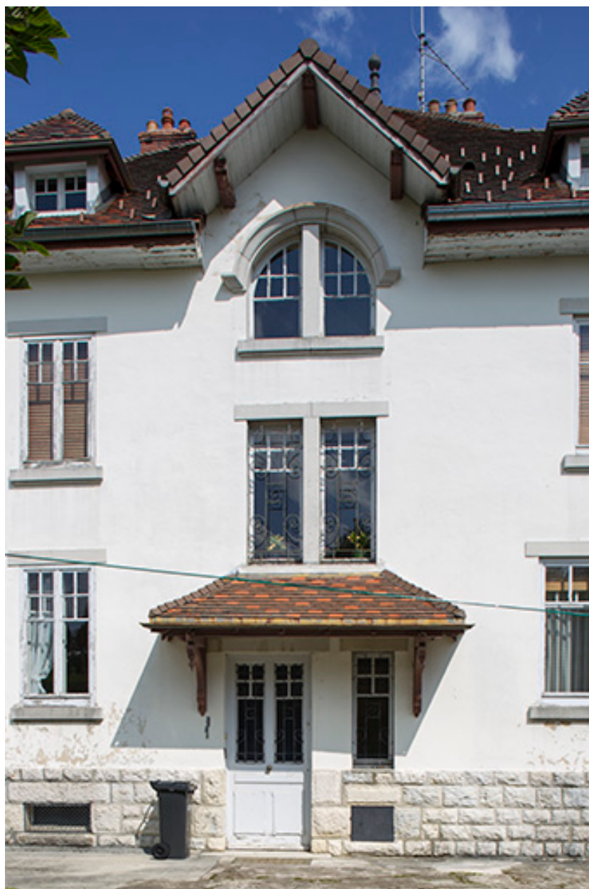
Façade latérale gauche : la travée centrale.
