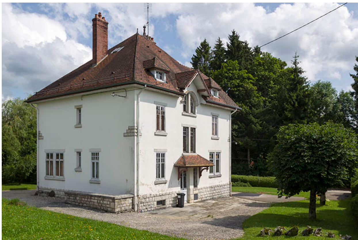
Façades postérieure et latérale gauche.
