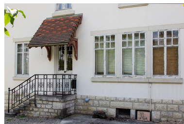
Façade latérale droite : entrée et fenêtres multiples. Phot. Sonia Dourlot IVR43_20142501767NUC2A
