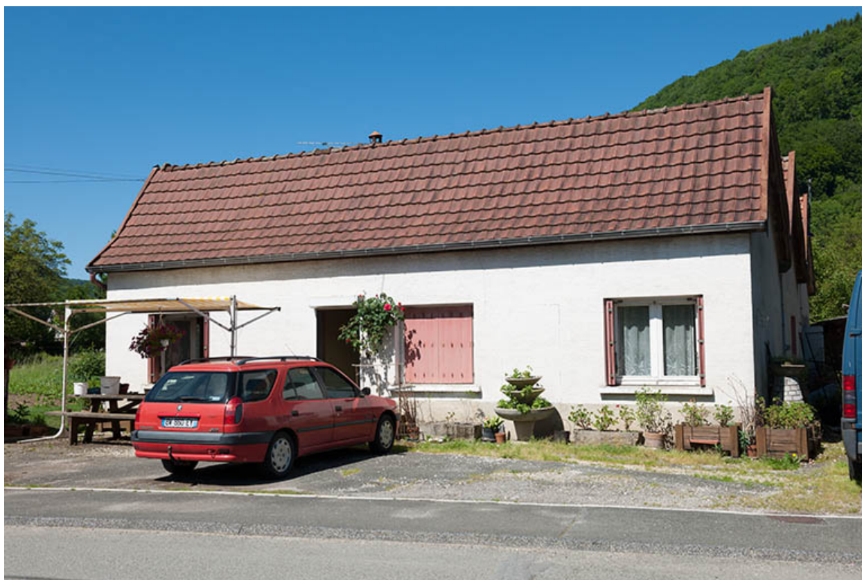
Vue depuis la rue de Rochedane.
