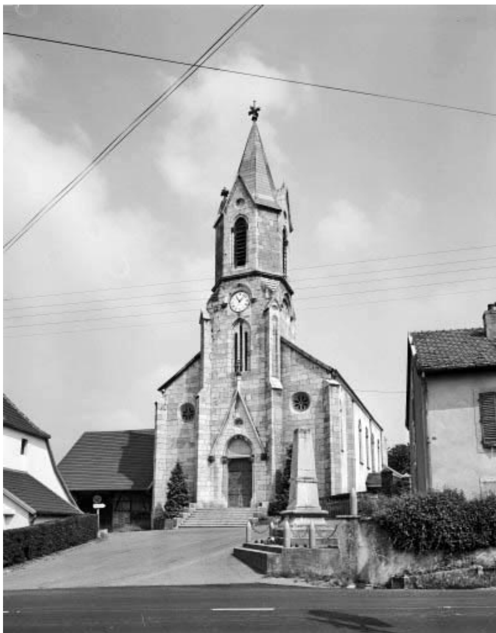
Façade antérieure au Sud.
