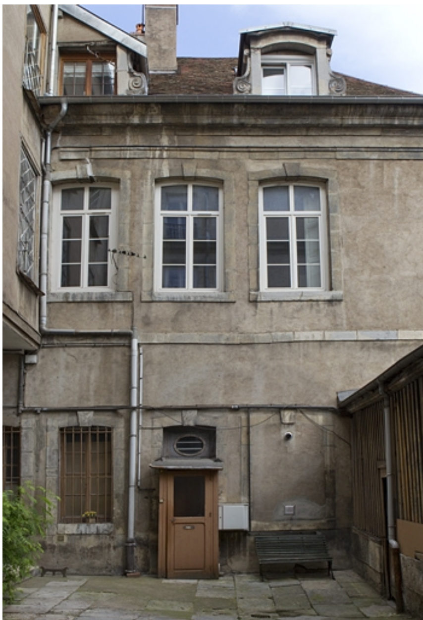
Vue d'ensemble de l'aile droite sur cour.
