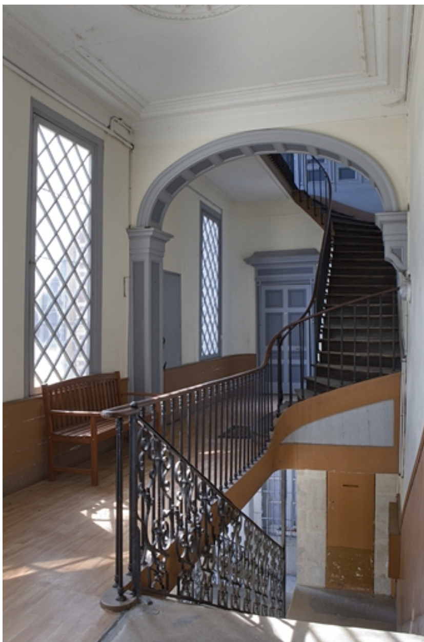
Vue des volées supérieures de l'escalier.
