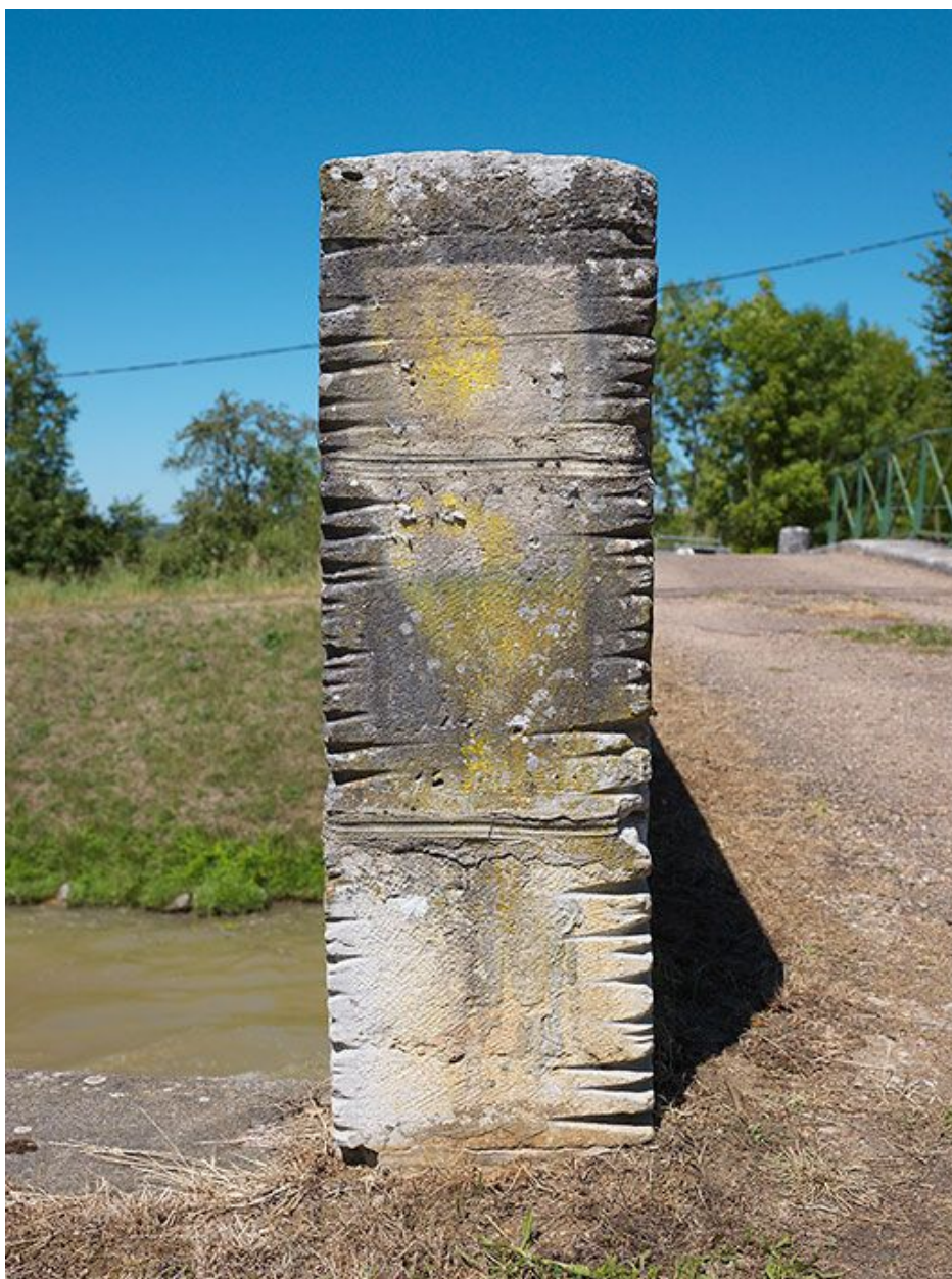
Détail des marques de halage.
