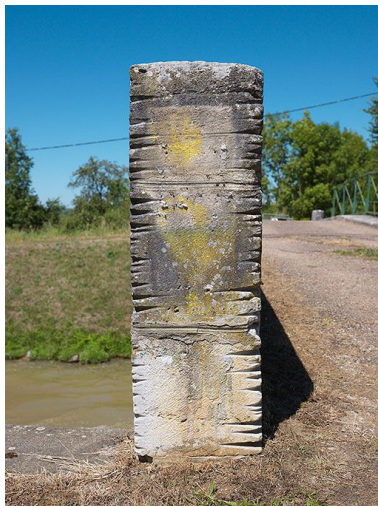
Détail des marques de halage. Phot. Thierry Kuntz IVR26_20135800201NUC4A
