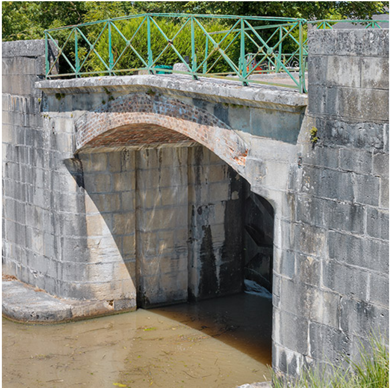
Vue rapprochée de la voûte en brique.
