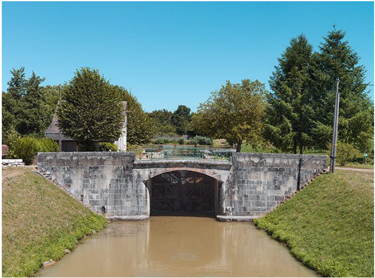
Vue d'ensemble du pont.
