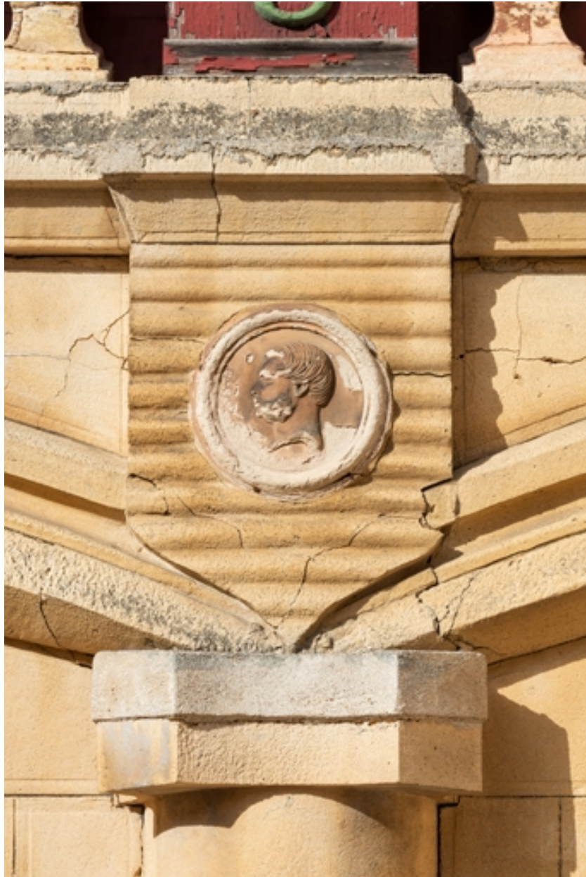
Bas-relief sur l'élévation antérieure de la maison.
