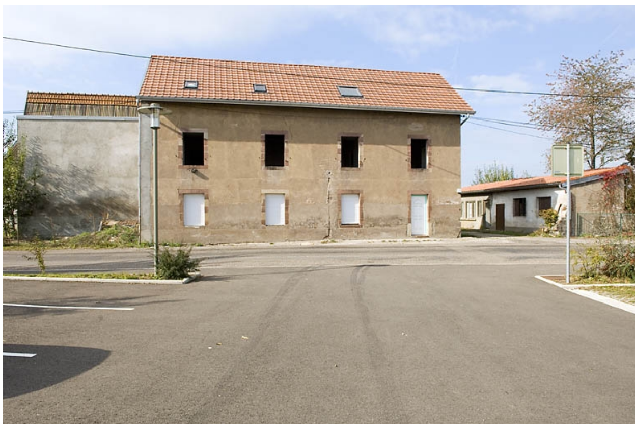
Ancien atelier de fabrication (?). Façade sur rue.
