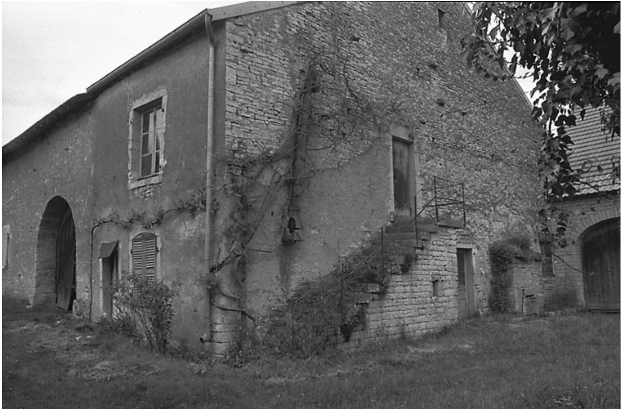
Vue de l'habitation.
