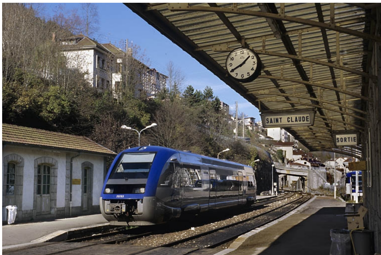
Vue d'ensemble en gare de Saint-Claude.
