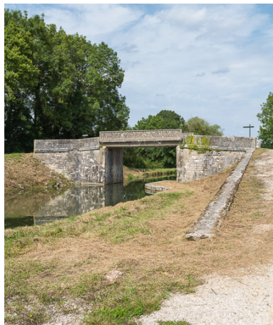
Vue du pont.
